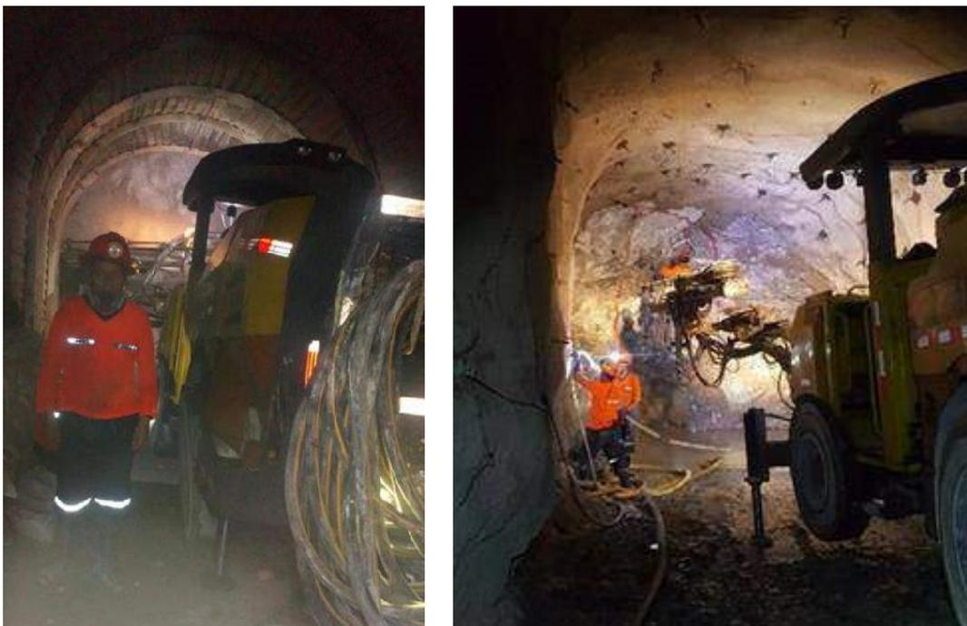
Figura 2 — Perforación de la Rampa Patrick III con Jumbo Hidráulico
