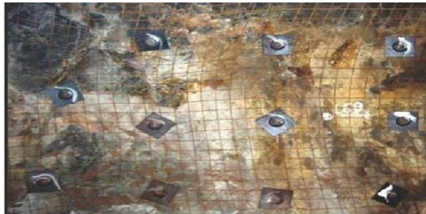
**Figura 23 — Sostenimiento con Malla Electrosoldada**
