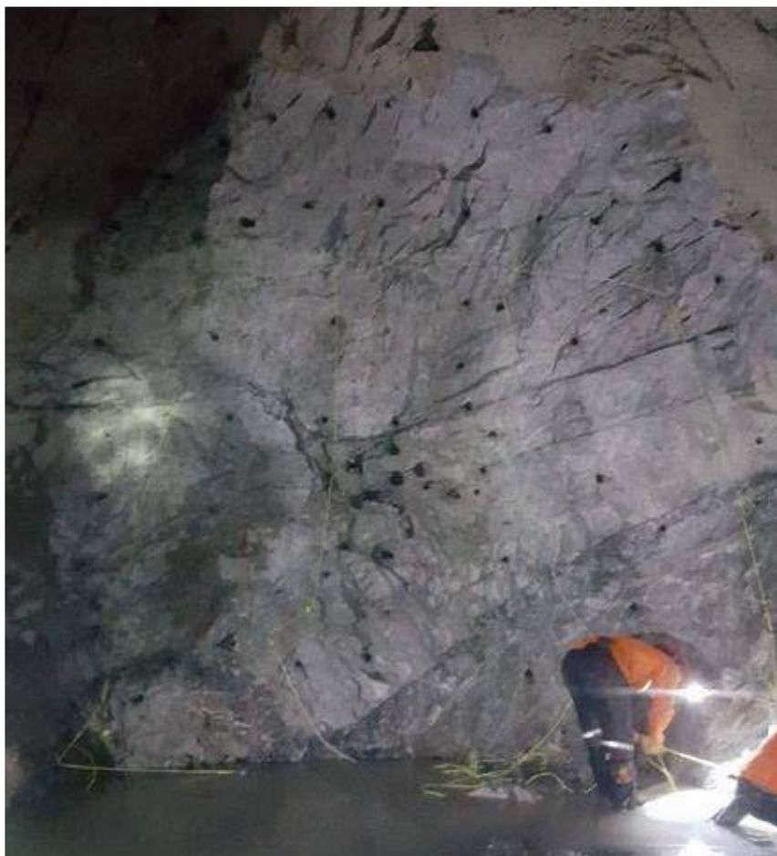
**Figura 30 — Malla de Perforación y Carguío de los Taladros**
