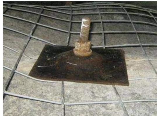
**Figura 9 — Pernos Colocados Correctamente, Espaciamiento y Colillas a Estándar**
