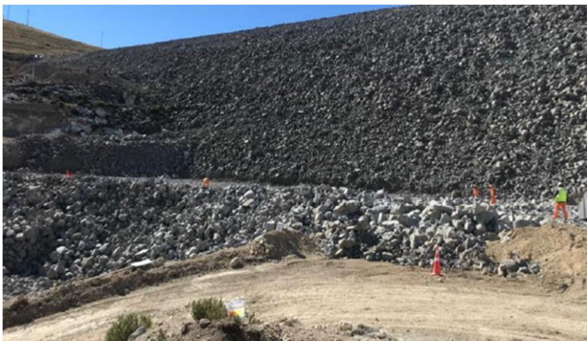
**Figura 26 — Colocación relleno estructural material tipo 1**
