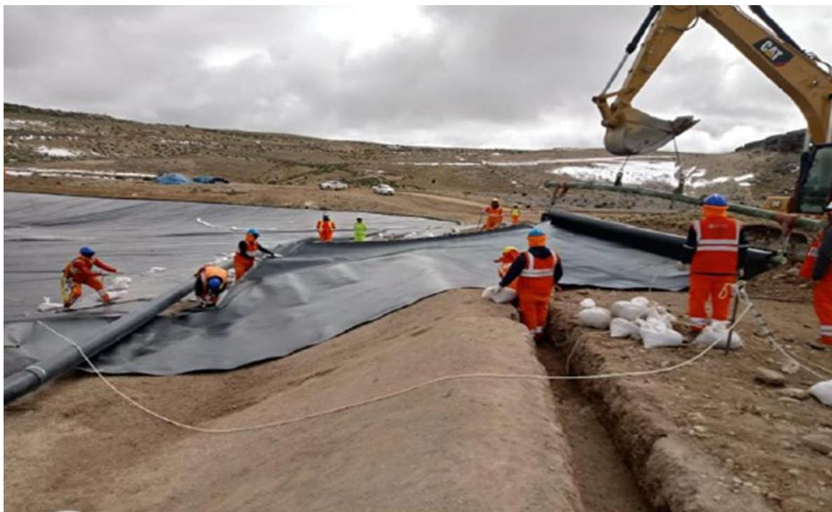
**Figura 28 — Despliegue e instalación de geomembrana**
