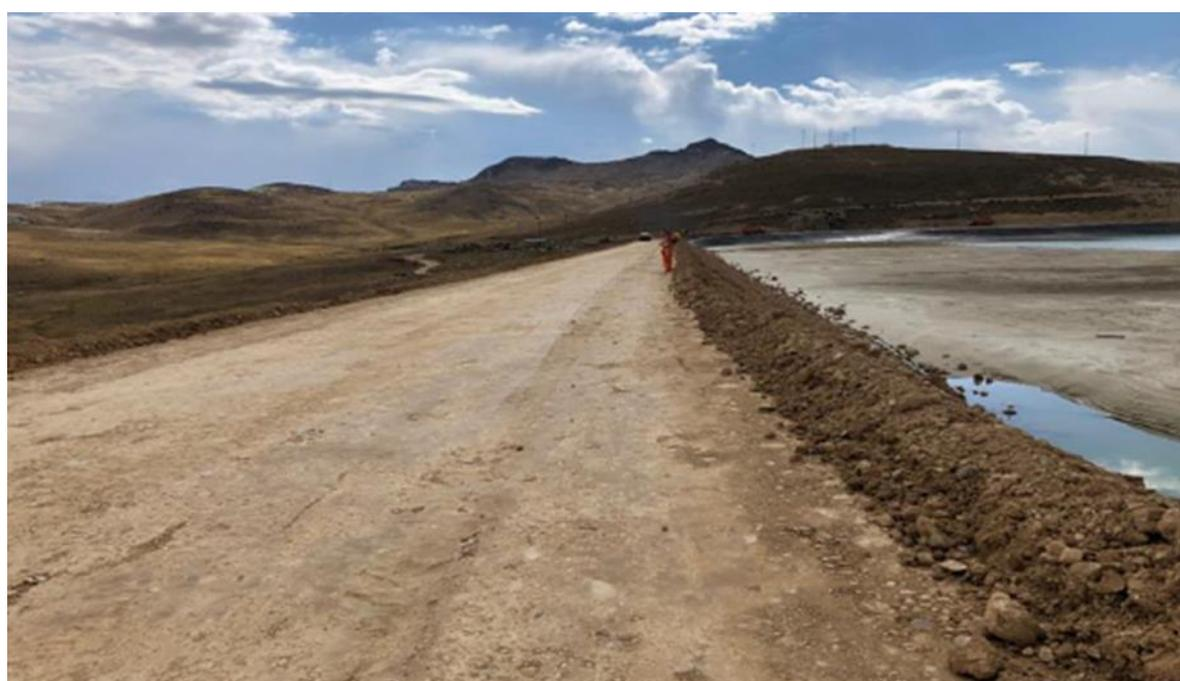
**Figura 27 — Relleno estructural material tipo 1 dique principal**
