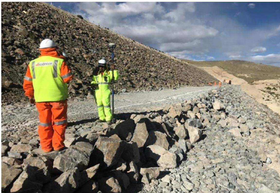
**Figura 24 — Levantamiento topográfico en cada capa liberada**
