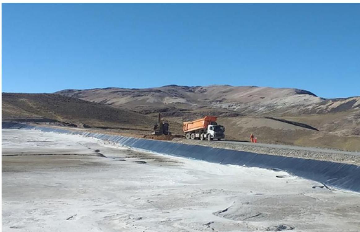
**Figura 25 — Relleno de capas en dique contención**
