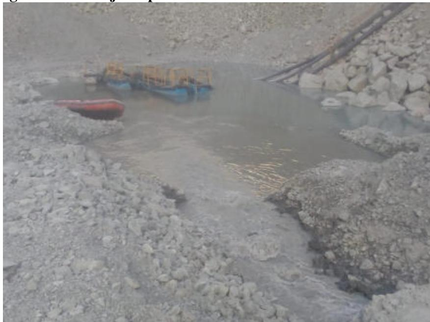
**Figura 35 — Tajo paralizado por trabajos de bombeo**
