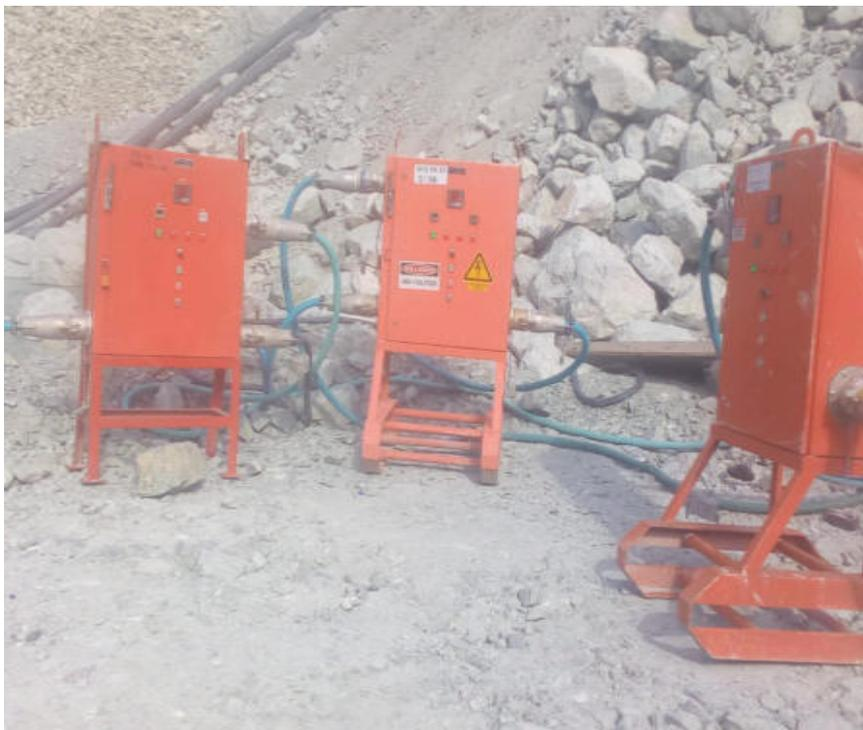
**Figura 39 — Sistema de bombeo de agua blending**
