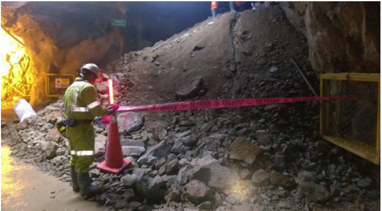
Figura 41— Refuerzo a los colaboradores sobre la importancia de señalizar y bloquear el área de trabajo antes de iniciar las actividades.
