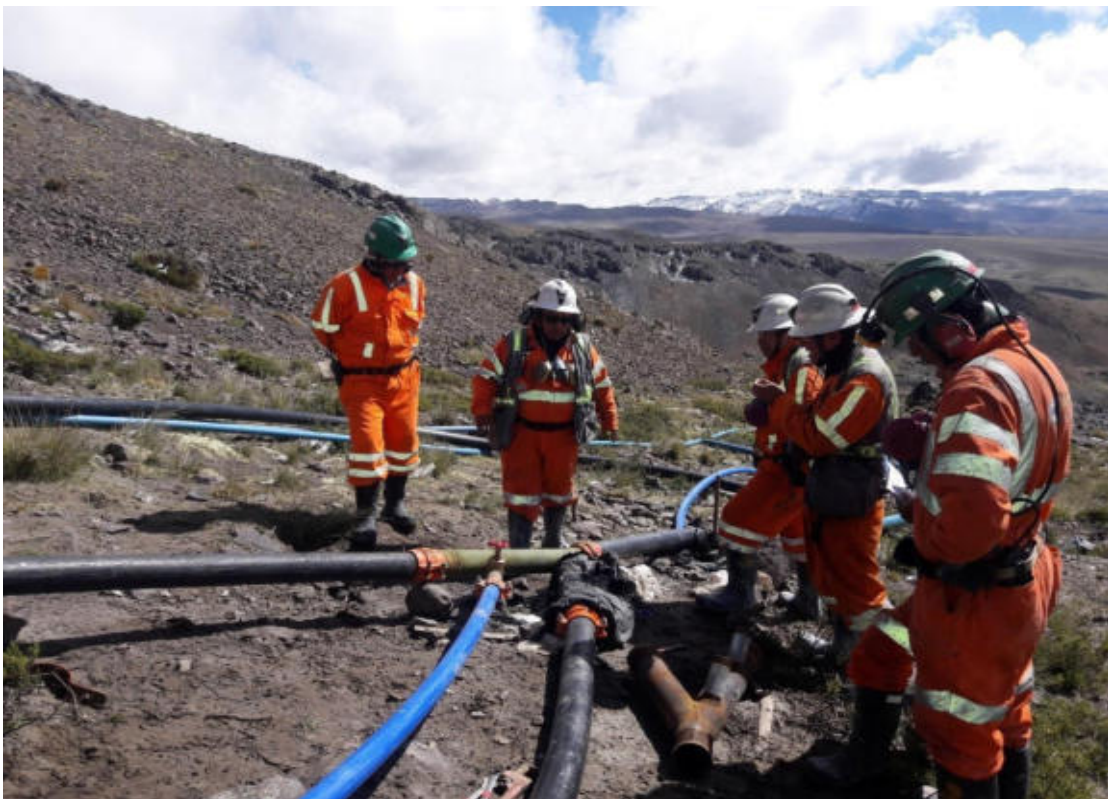
Figura 48— Entrenamiento al grupo de soporte sobre la forma correcta de observación a colaboradores, y el correcto llenado de la cartilla de seguridad.
