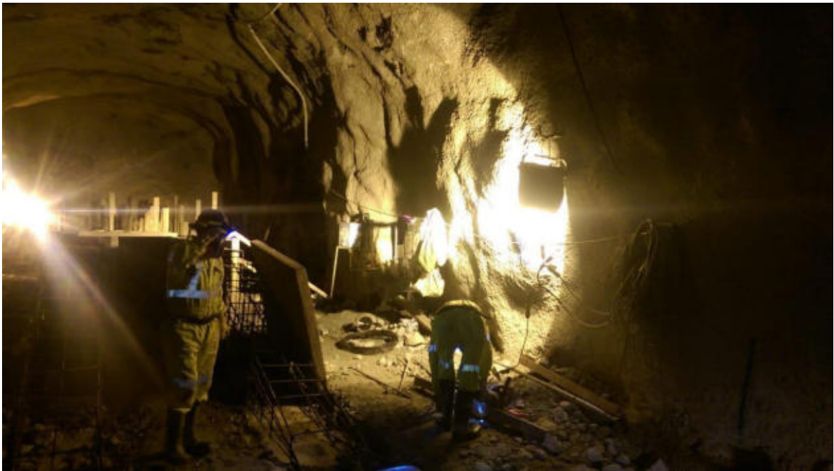
Figura 43— Observación de actividades críticas y generales en el área de trabajo donde se realiza encofrado y enfierrado de muro.
