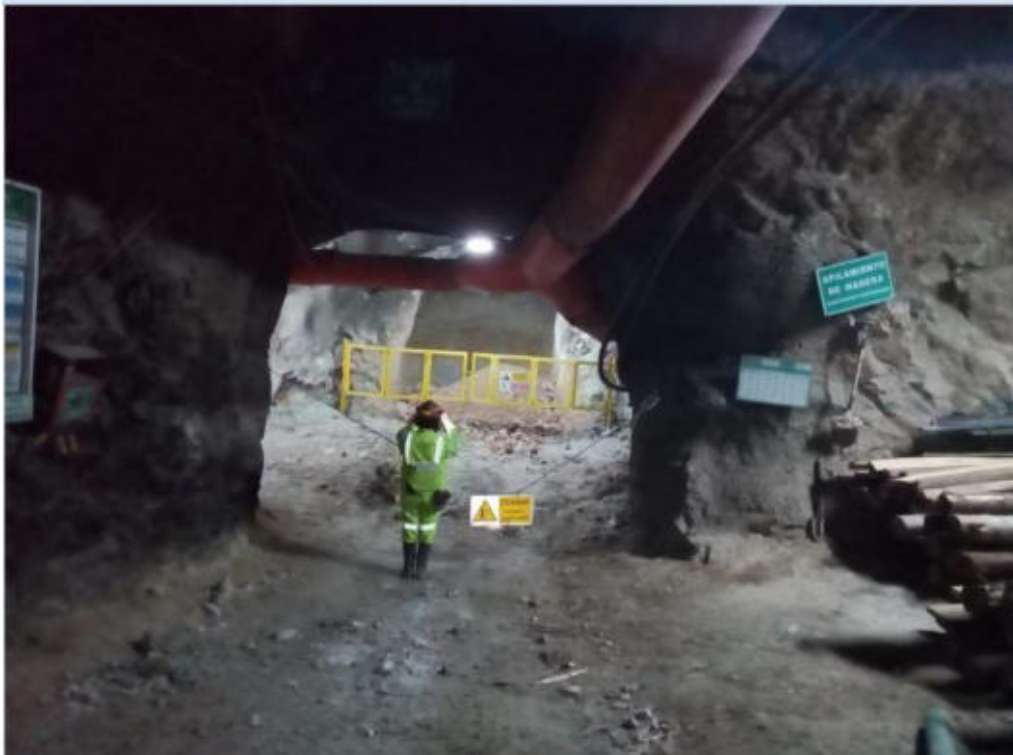
Figura 57— Supervisión de las condiciones del área de trabajo antes de iniciar con la intervención de estos.
