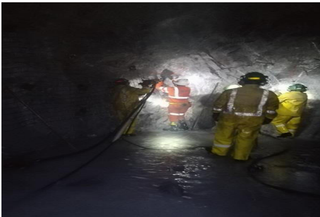
Figura 33 — Observación de actividades críticas y generales del líder observador según el PETS de trabajo de sostenimiento.
