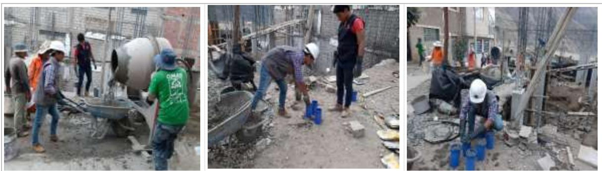
Figura 35 — Proceso de elaboración de probetas estándares de concreto en la obra
