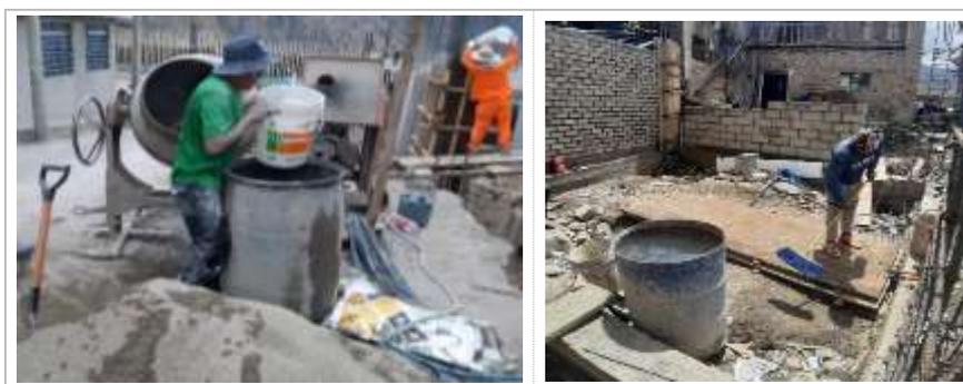
**Figura 31 — Almacenamiento del agua de mezclado en la obra**
