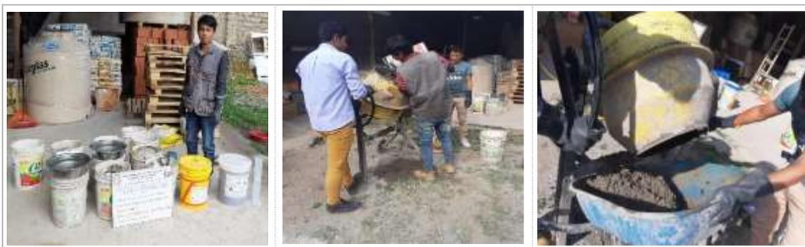
Figura 21 — Muestreo de materiales e insumos y mezclado de la masa del concreto
