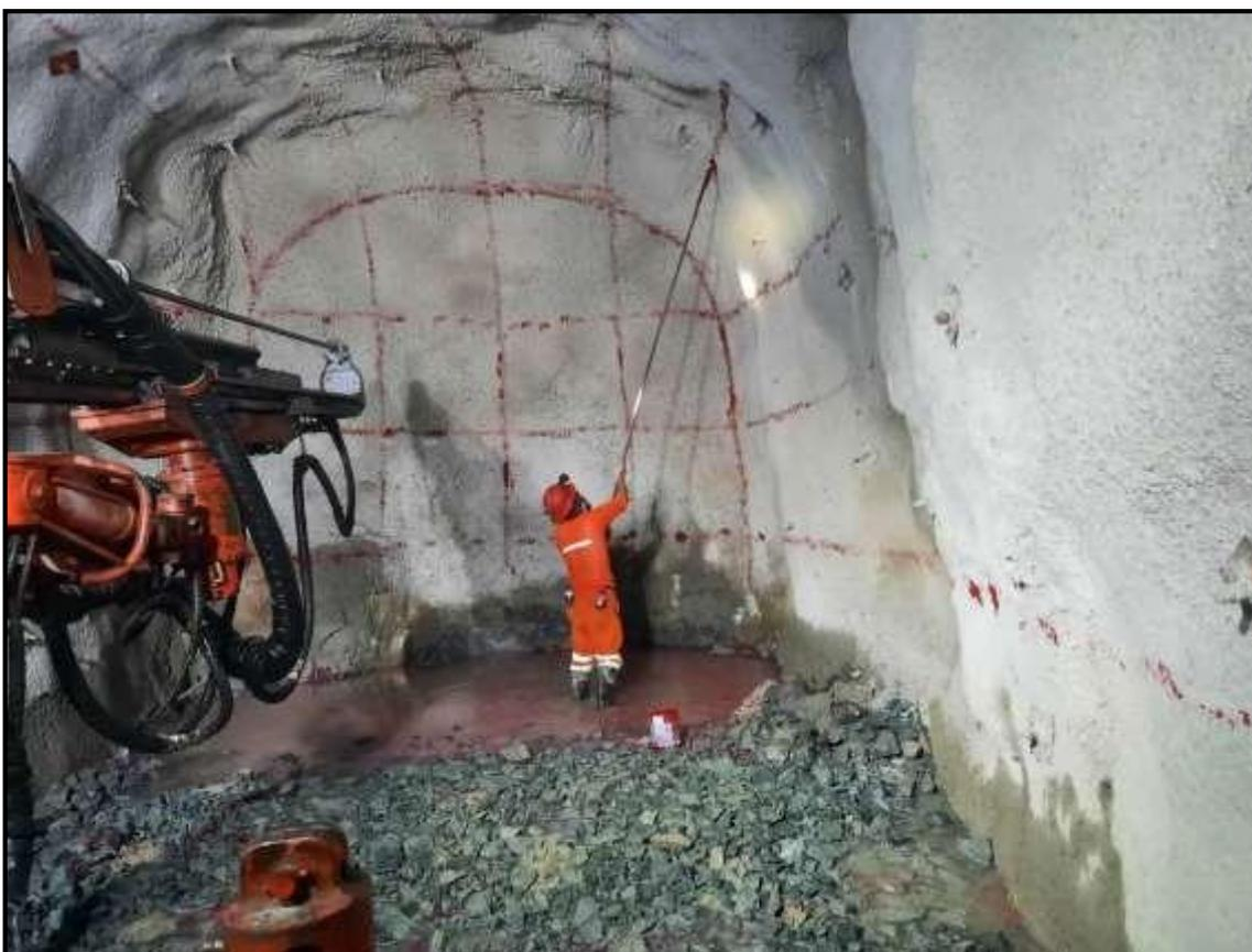
Figura 40 — Pintado de malla en CX2682 sección de 4.50 m x 4.20 m
