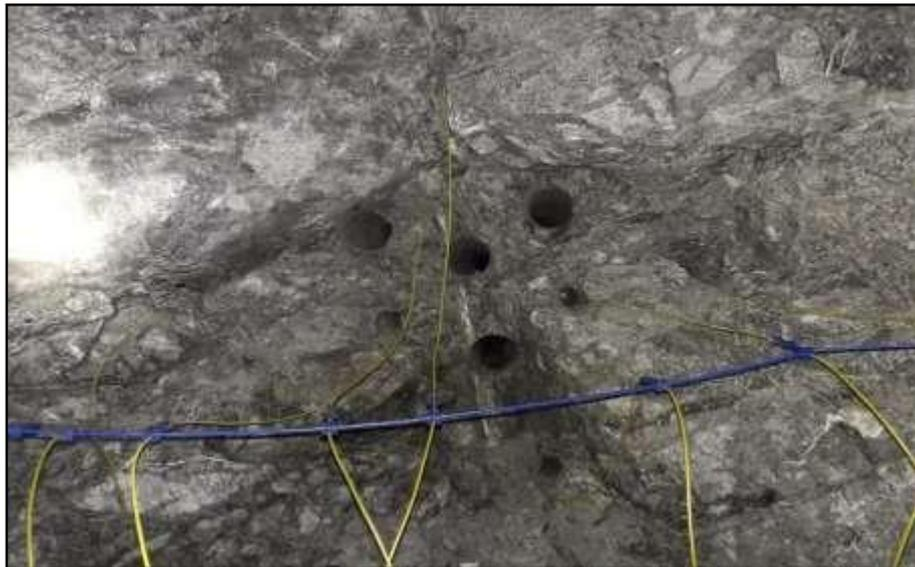
**Figura 14 — Taladros cargados con explosivo y taco en el CX 2682**
