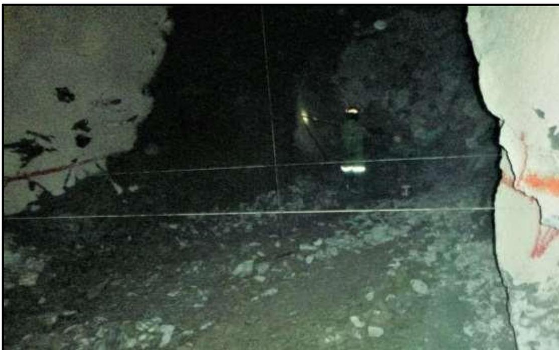
Figura 39 — Pintado de dirección y gradiente en CX2682 sección de 4.50 m x 4.20 m
