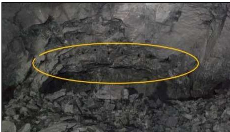
Figura 20 — Corona completa después de la voladura en la CX 2682
