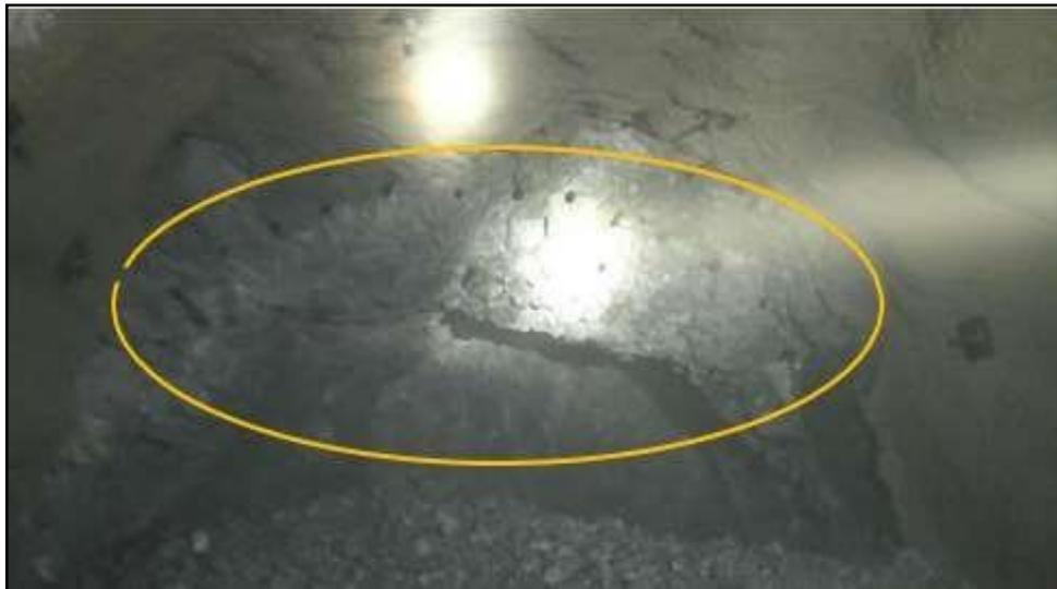
**Figura 21 — Corona completa después de la voladura en el CX2682**
