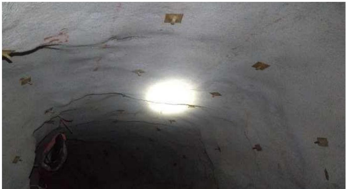
**Figura 25 — Control de la sección, sobre todo en la parte de la corona CX2682**
