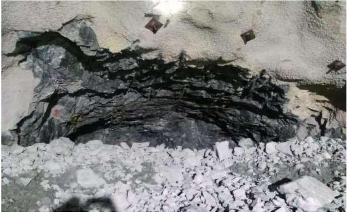
**Figura 26 — Resultado de la voladura con recorte del CX2682**
