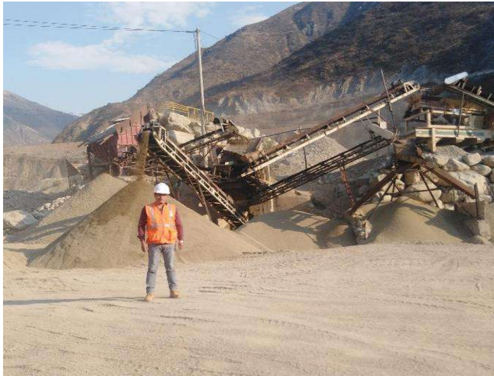
Figura 19 — Proceso de producción de los agregados
