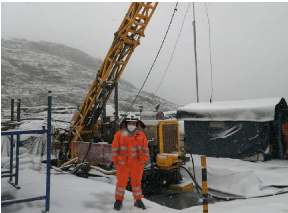
Figura 65 — Plataformas de perforación con la maquina CS14
