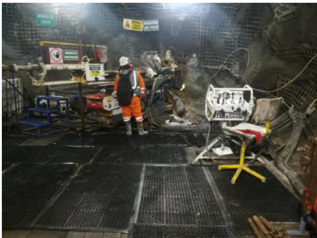
Figura 26 — Inspección y nivelación de la máquina para el cambio de dirección del siguiente sondaje
