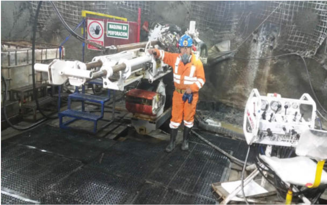
Figura 62 — Colocación de pisos antideslizantes en la cámara
