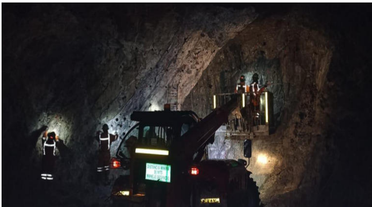
Figura 51 — Actividad de carguío de taladros en el frente de trabajo
