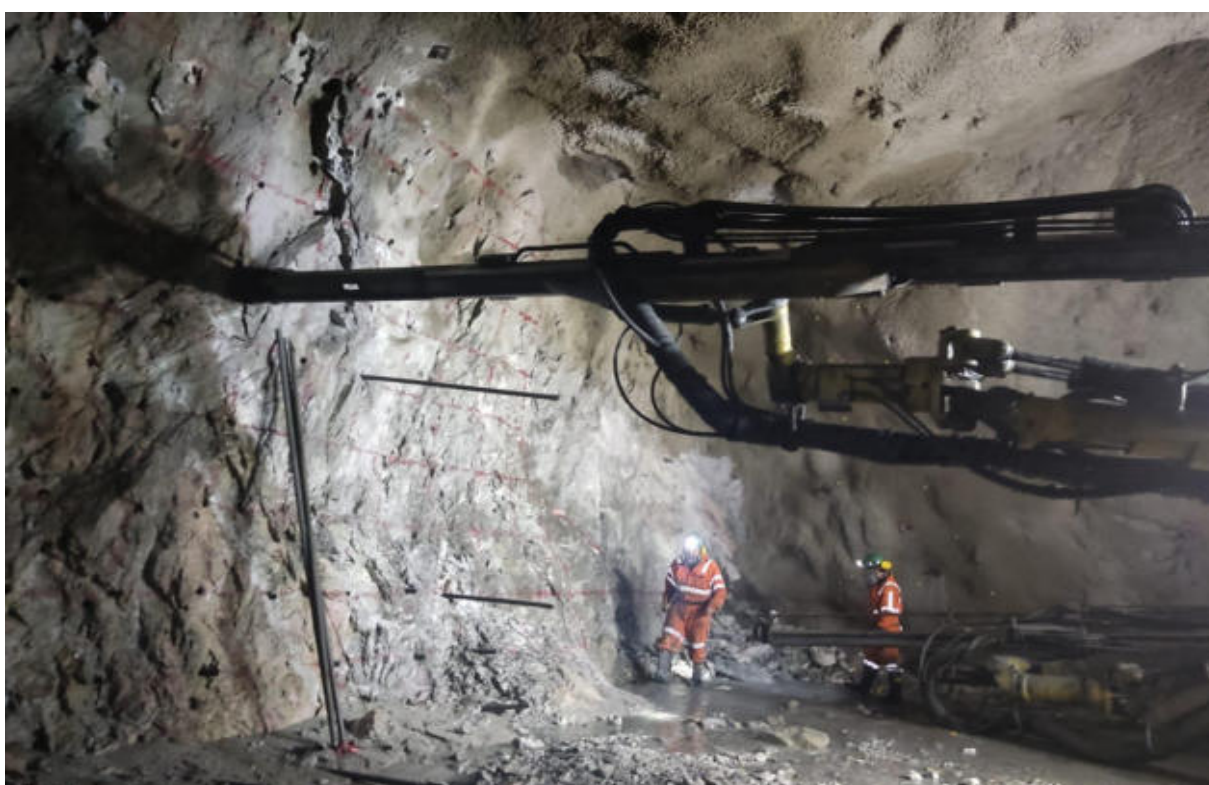
Figura 50 — Perforación de taladros en el frente de trabajo
