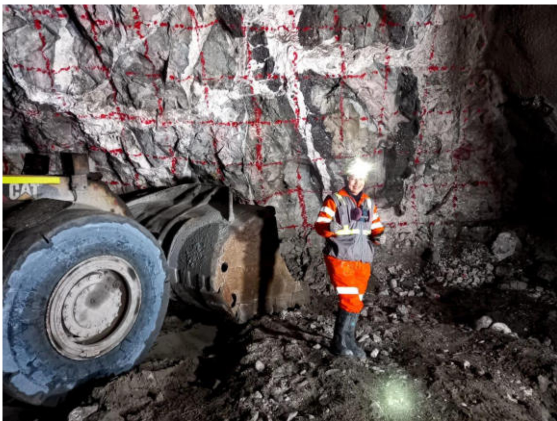
Figura 62 — Trabajos de supervisión después del marcado de malla de perforación
