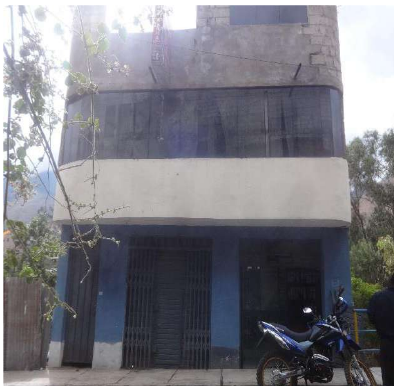
Figura 30 — Vista frontal de la vivienda en evaluación
