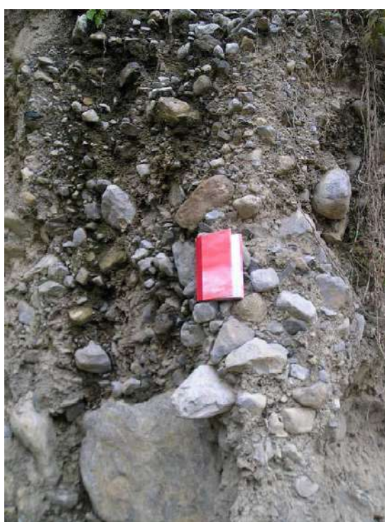
Figura 2 — Depósito aluvial en la escarpa de talud Extraído de (INDECI, 2007 pág. 34)
