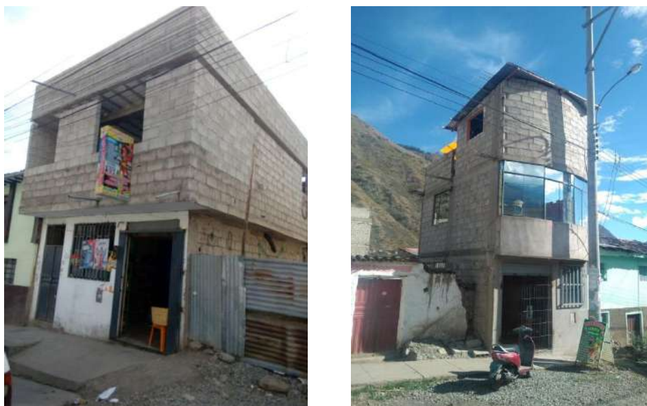
Figura 32 — Vista de parapetos inadecuados en una construcción
