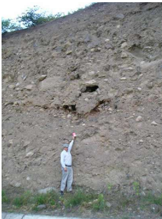
Figura 3 — Depósito coluvial en el corte de talud de carretera Extraído de (INDECI, 2007 pág. 35)
