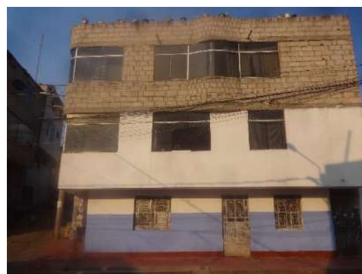
Figura 11 — Calidad del sistema resistente, albañilería y mortero de buena y baja calidad no muy homogéneas
