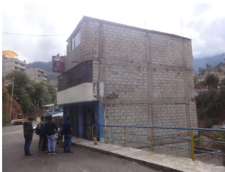
Figura 33 — Estado de conservación de vivienda en evaluación
