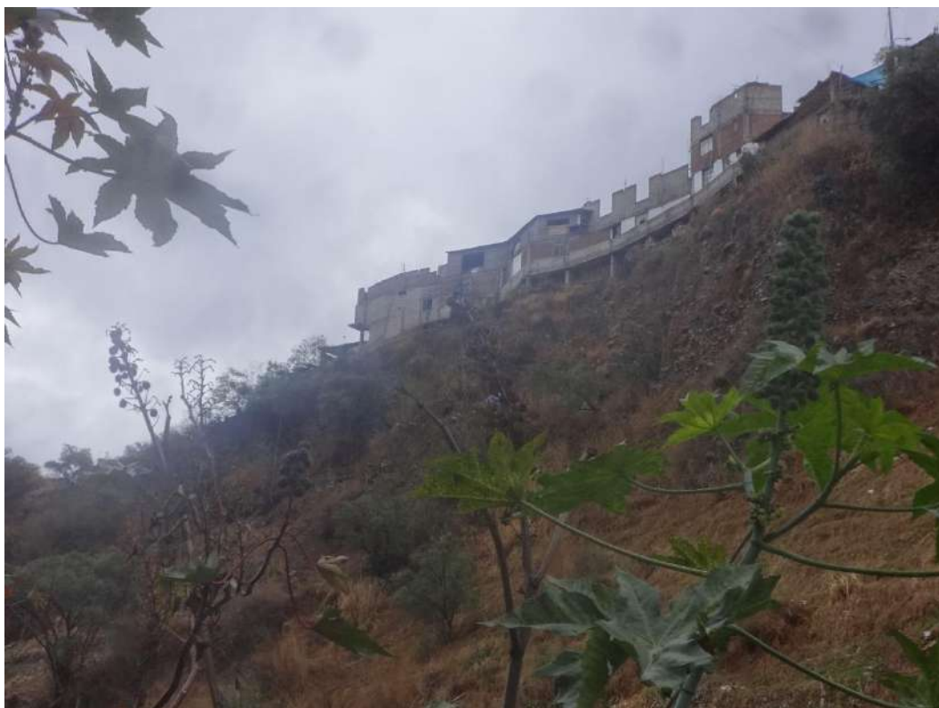
Figura 49 — Vivienda ubicada en talud con riesgo a sufrir un deslizamiento lateral
