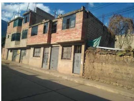
Figura 11 — Calidad del sistema resistente, albañilería y mortero de buena y baja calidad no muy homogéneas
