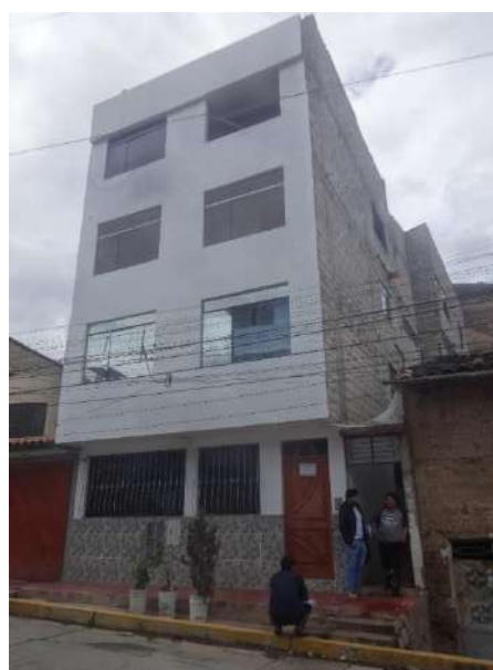
Figura 18 — Estado de conservación; muros, columnas y techo en buena condición
