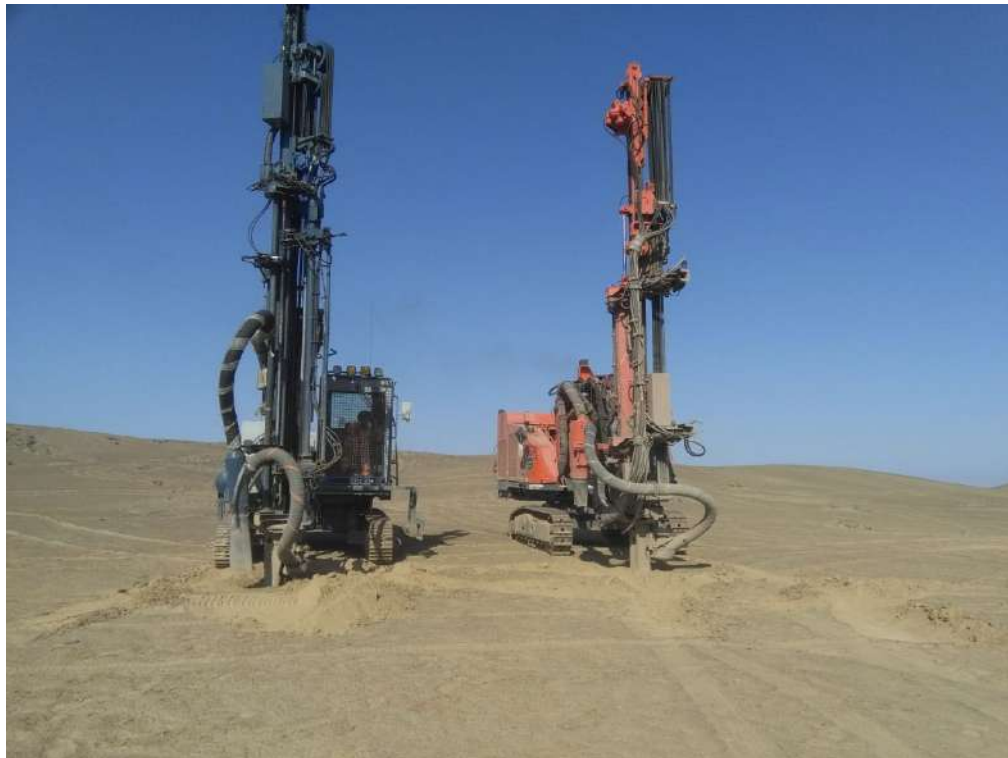
Figura 76 — Perforadoras fuera del radio de influencia de voladura
