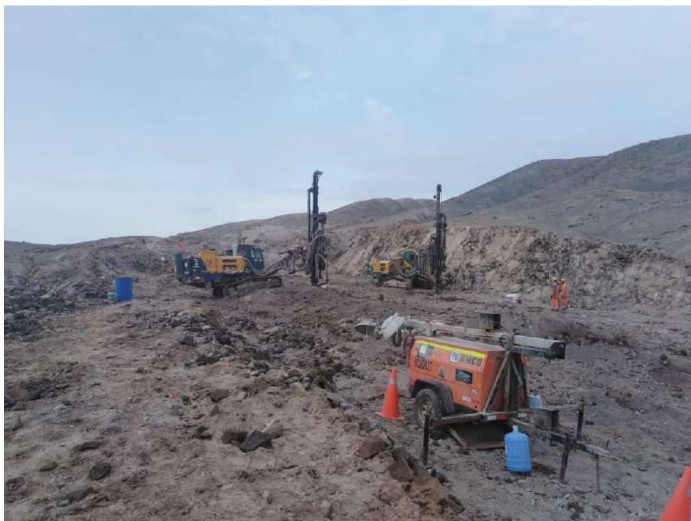
Figura 77 — Rock drill Junjin en el frente de trabajo
