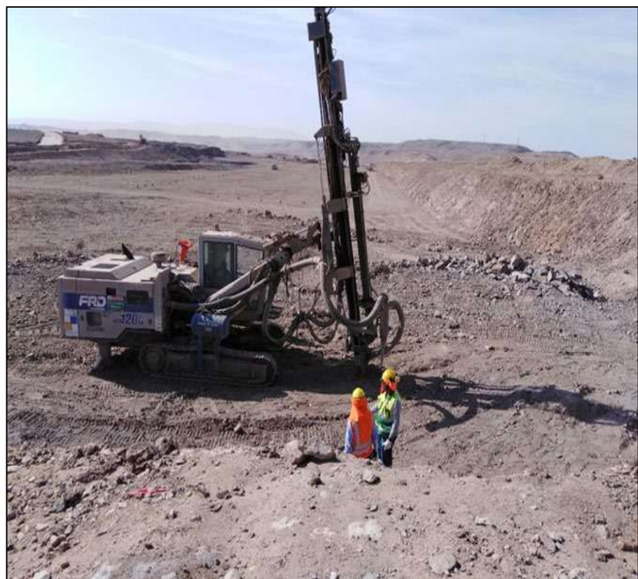
Figura 73 — Plataforma de perforación
