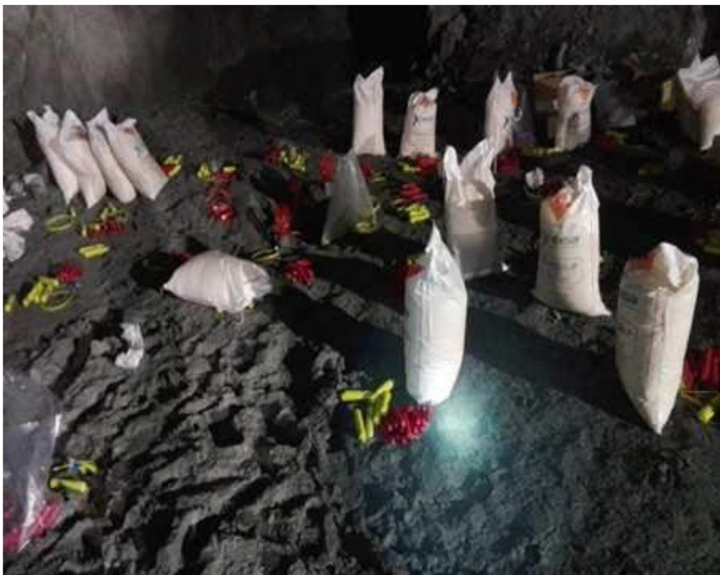
Figura 54 — Carguío de taladros con ANFO y con detonadores no eléctricos para realizar la voladura de slot en negativo.
