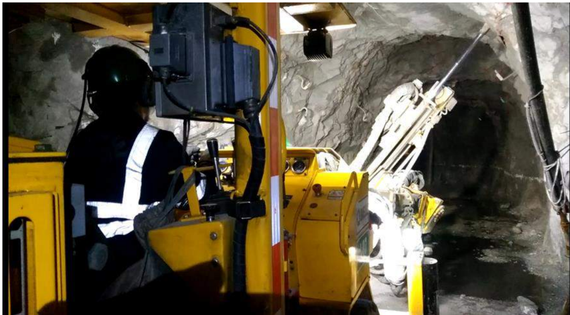
Figura 45 — Posicionamiento de equipo para la perforación de taladros largos en negativo.
