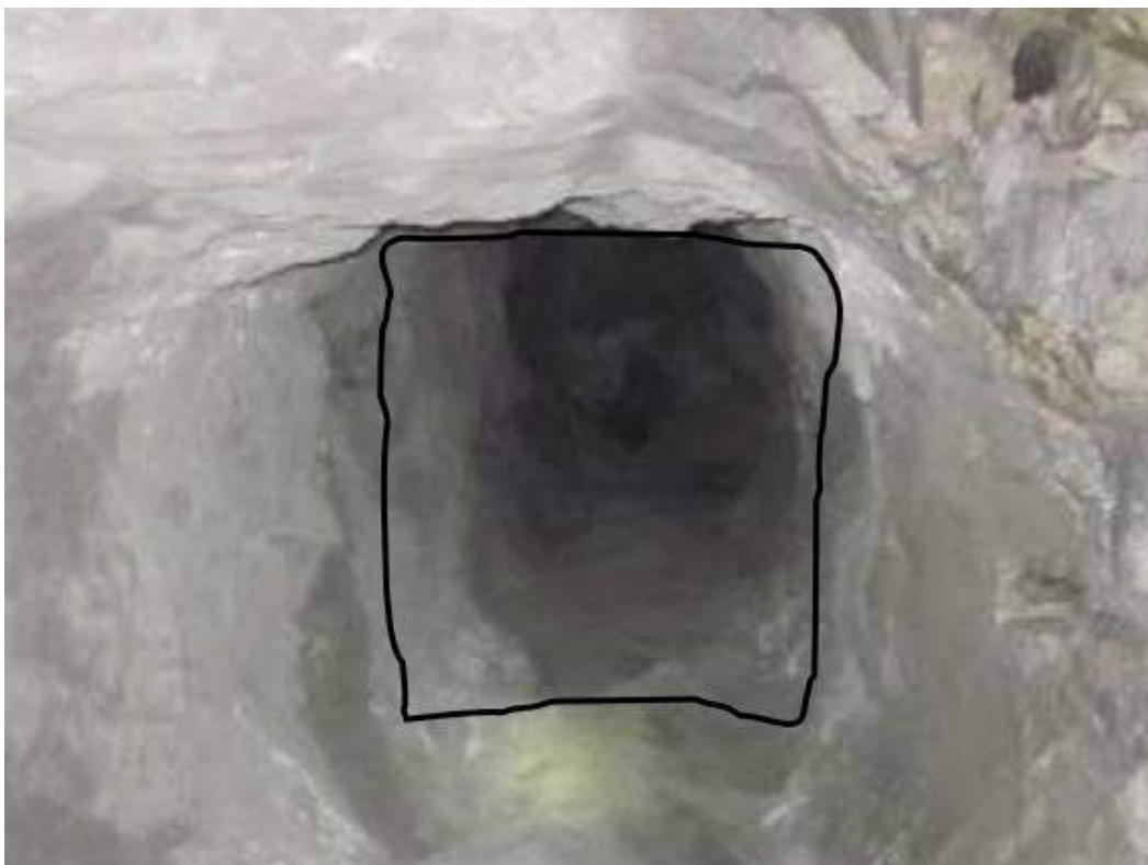
Figura 56 — Vista del slot después de realizar la voladura.
