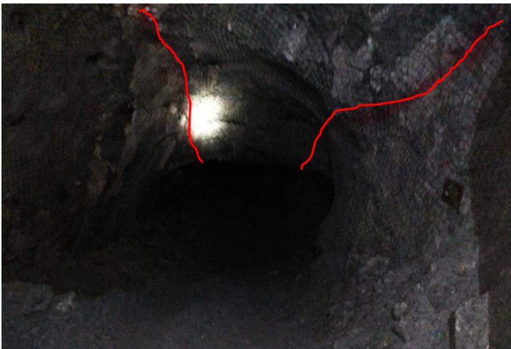
Figura 50 — Pintado de la estructura del primer nivel con RMR de 45, con sostenimiento malla y Split set.
