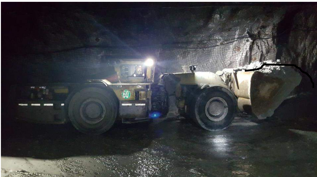
Figura 58 — Relleno de tajo con scoop-tramp CAT R1300, de capacidad de 4.2 yd 3 .
