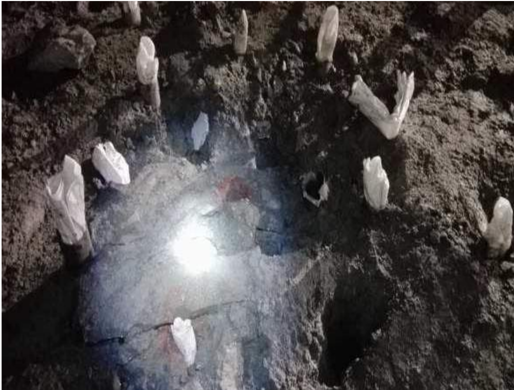
Figura 53 — Vista desde la parte superior de Taladros perforados en negativo con sus respectivos costales y tubos de PVC para evitar que se tapen.
