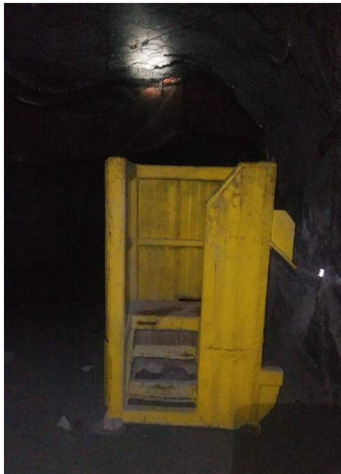
Figura 48 — Refugio con caceta para el resguardo del operador de scoop-tram y la operación segura con telemando.
