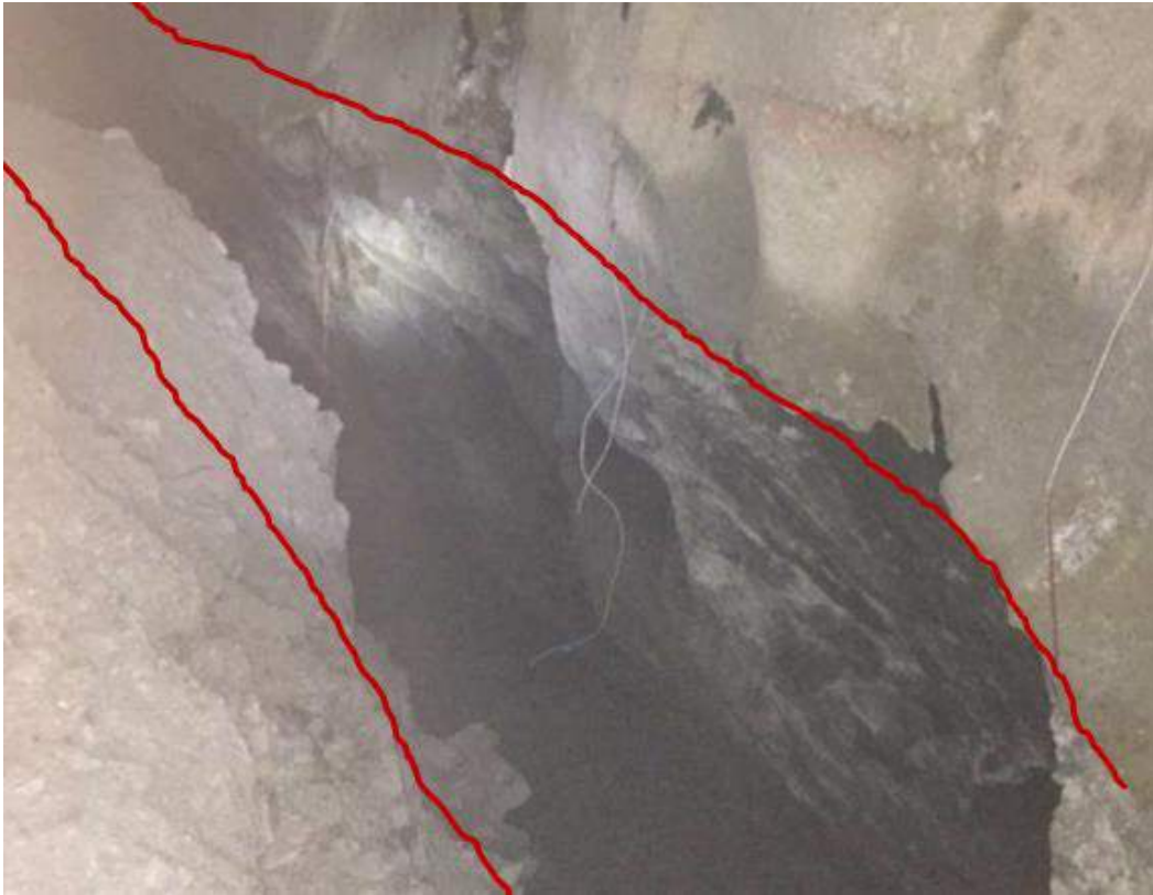
Figura 57 — Secciones después de realizar la voladura de taladros en negativo.
