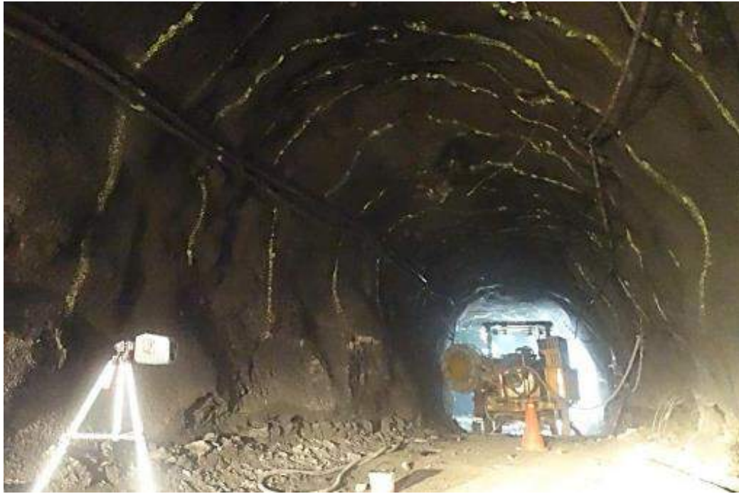
Figura 51 — Pintado de secciones y puntos para el inicio de perforación de los taladros largos en el tajo 1575.
