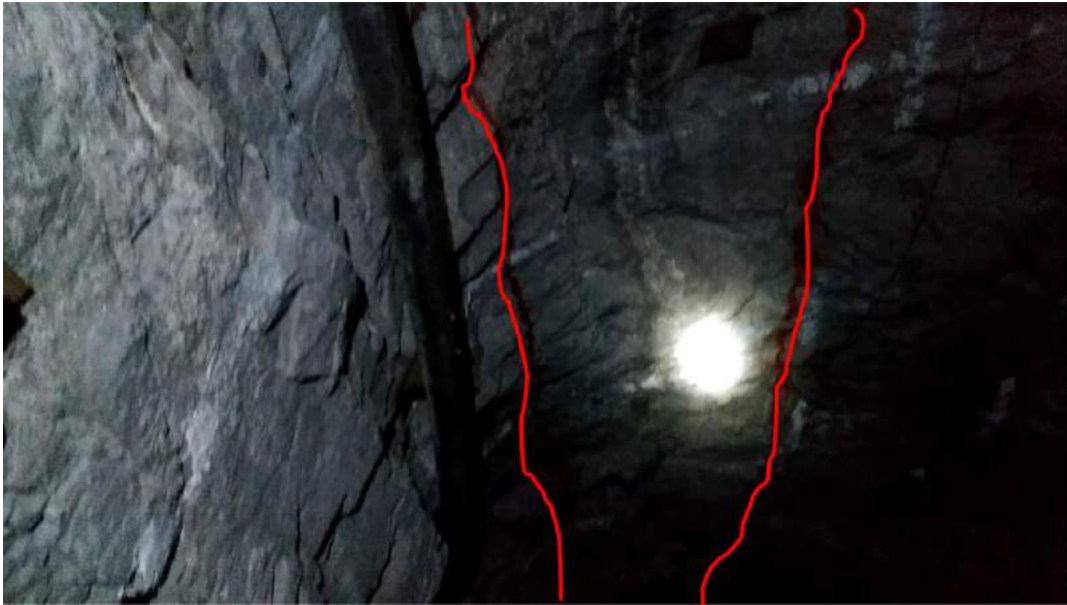
Figura 49 — Pintado de la estructura de la veta en TJ-1575 tercer nivel con RMR 55, con sostenimiento sistemático.
