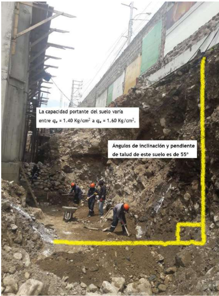
Fotografía 01: Excavación para la cisterna
