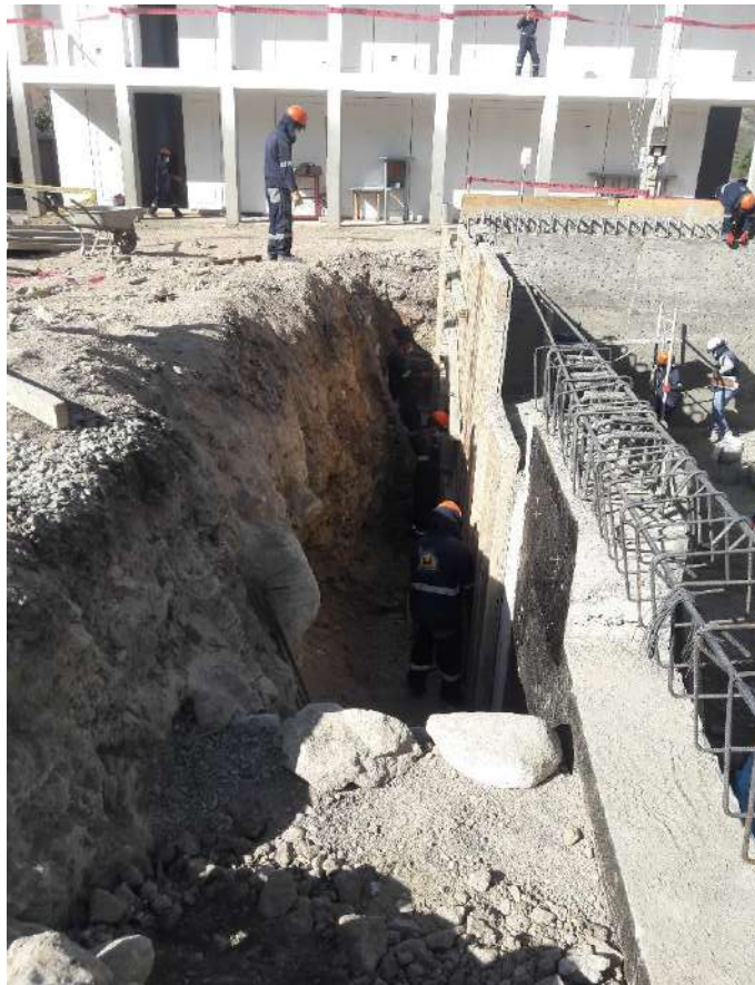
Fotografía 03: Desencofrado del muro de contención
