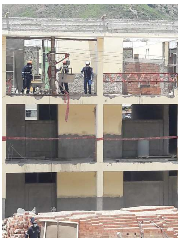
Fotografía 14: Medidas de seguridad de trabajos con la wincha
