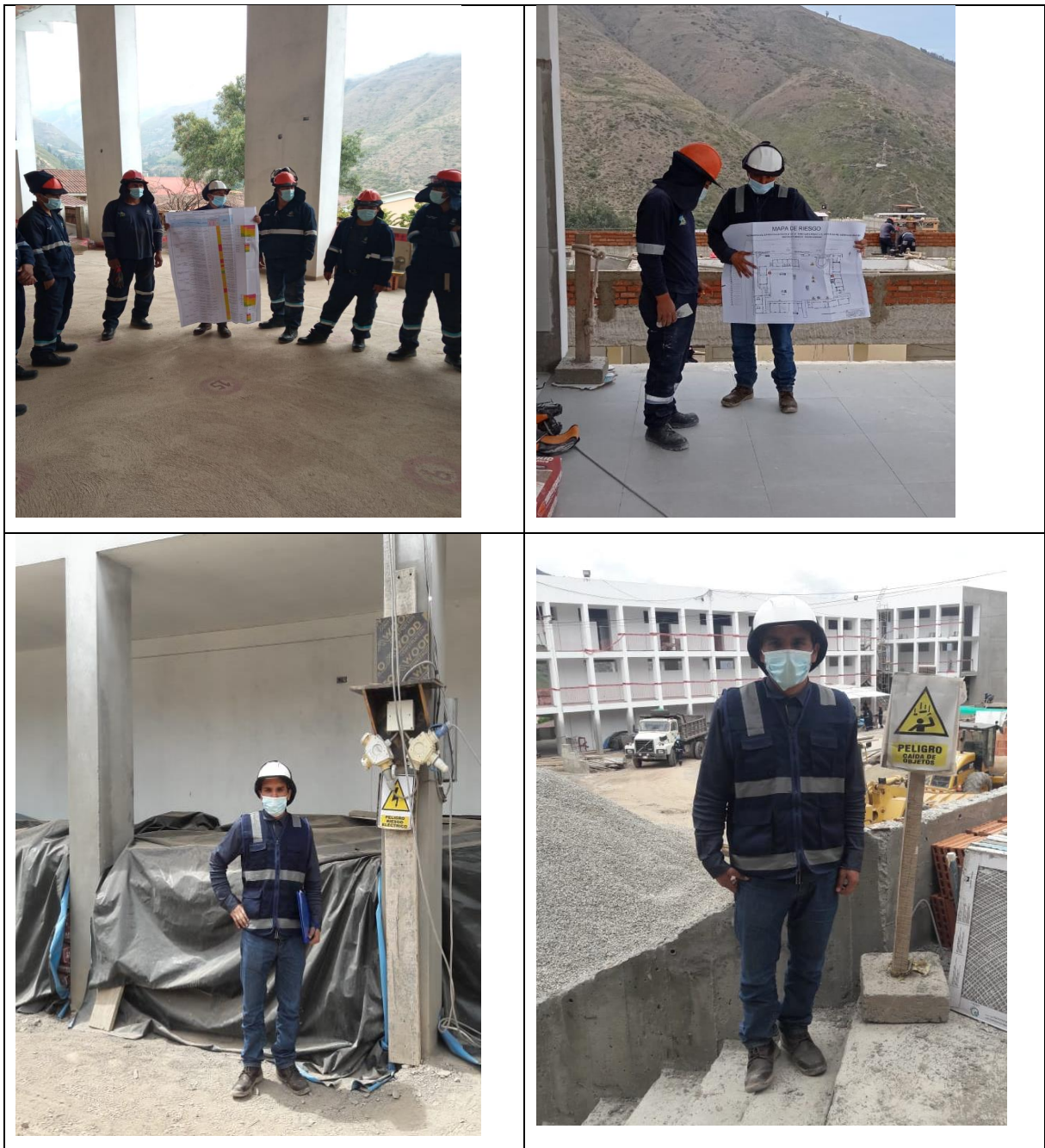
Figura 2 — Identificación de peligros y riesgos en la obra
