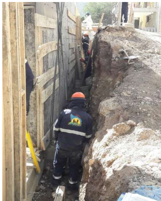
Fotografía 02: Desencofrado del muro de contención
