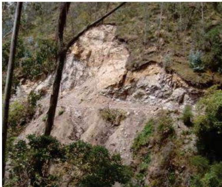
**Figura 54** — Desprendimiento de roca en talud kerapata.
