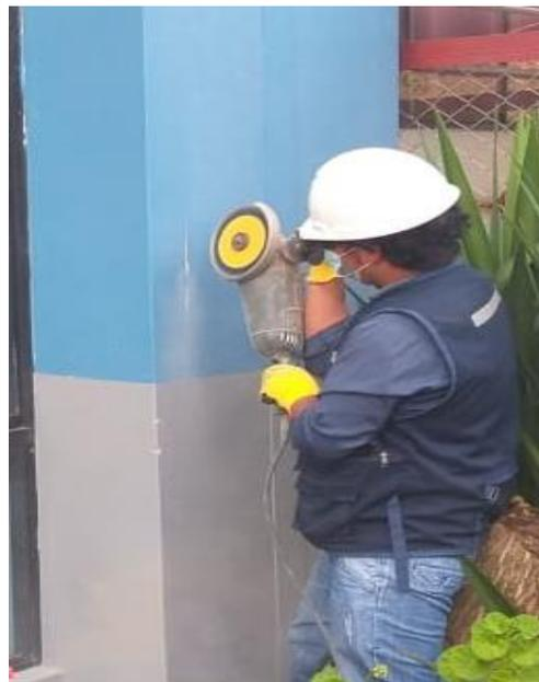
**Figura 77 — Retiro de acabado de elementos estructurales**
