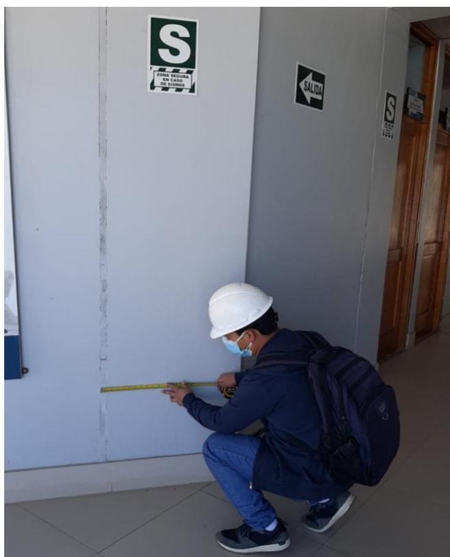
**Figura 67 — Vista de junta de aislamiento de tabiques**
