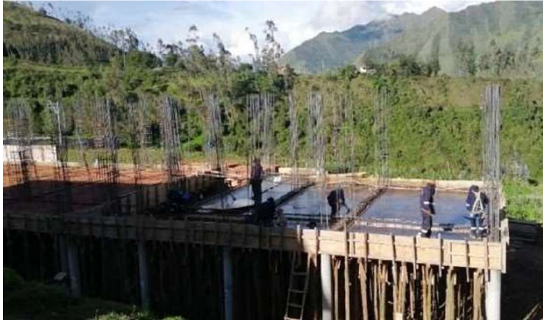
Figura 61 — Personal obrero realizando el encofrado de losa aligerada del bloque IV según especificaciones técnicas
