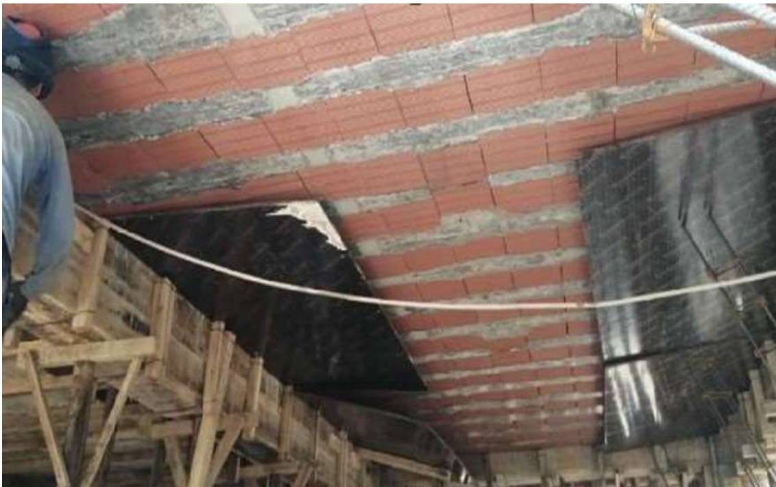
Figura 68 — Personal obrero realizando el desencofrado de losa aligerada
