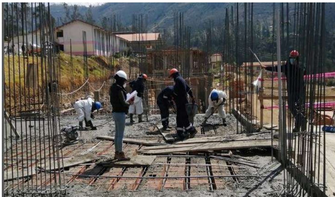
Figura 66 — Personal obrero ejecutando el vaciado de losa aligerada del bloque IV, con supervisión del personal técnico
