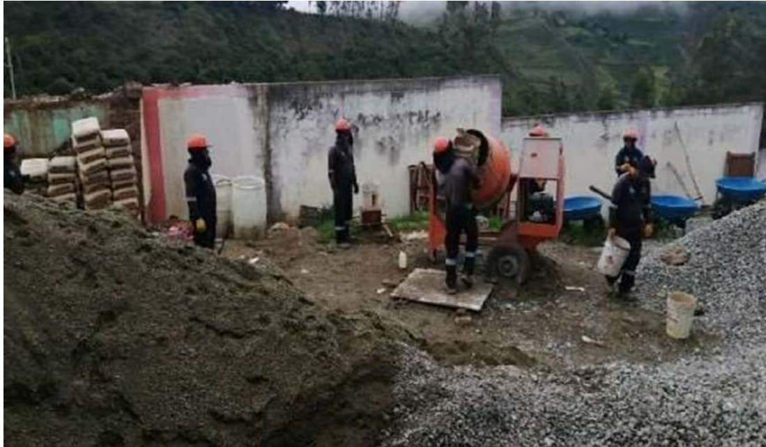
Figura 63 — Personal obrero realizando el preparado de concreto para vaciado de acuerdo a la dosificación dada
