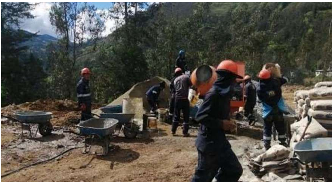
Figura 64 — Personal obrero realizando el preparado de concreto para vaciado de acuerdo a la dosificación dada
