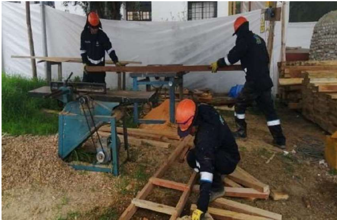
Figura 56 — Personal obrero efectuando el habilitado de formas para encofrados según especificaciones técnicas
