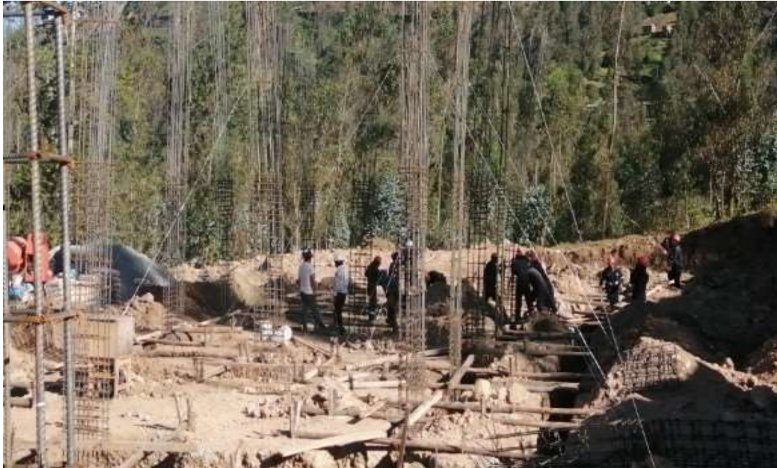
Figura 57 — Personal técnico efectuando el izado de acero para columnas del bloque IV
