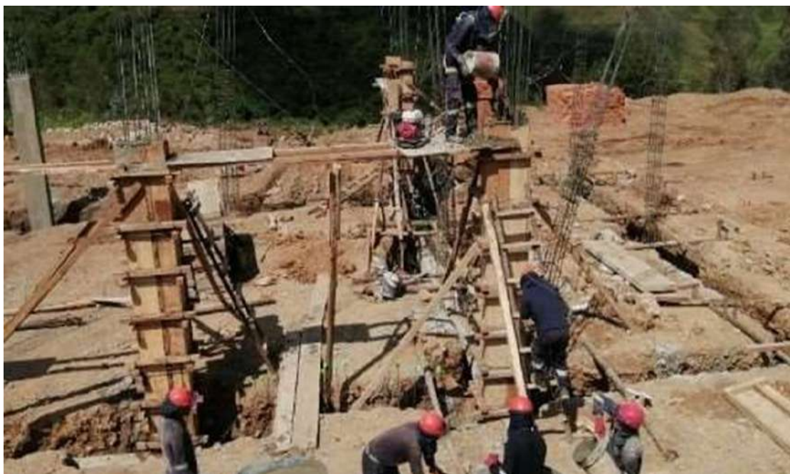
Figura 58 — Personal obrero ejecutando el vaciado de columnas del bloque IV
