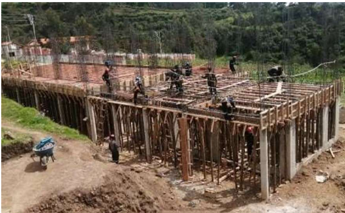
Figura 60 — Personal obrero realizando el encofrado de losa aligerada del bloque IV según especificaciones técnicas
