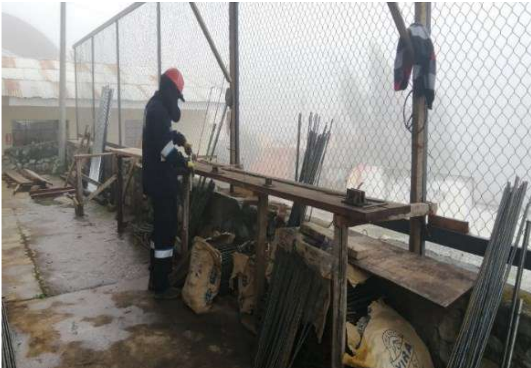
Figura 51 —Proceso de doblado y corte de acero (habilitado de acero), de acuerdo a los requerimientos específicos del proyecto
