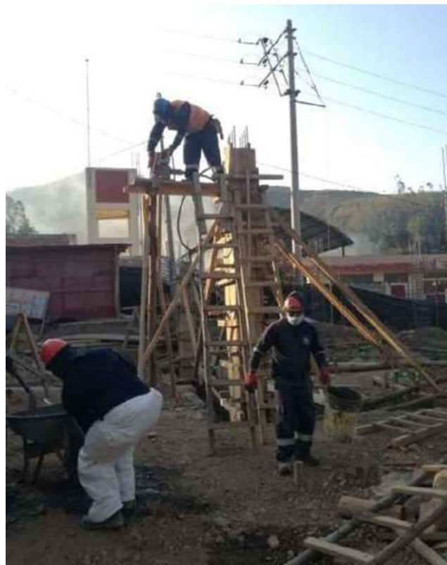
Figura 52 — Personal obrero realizando el encofrado de columnas del bloque I
