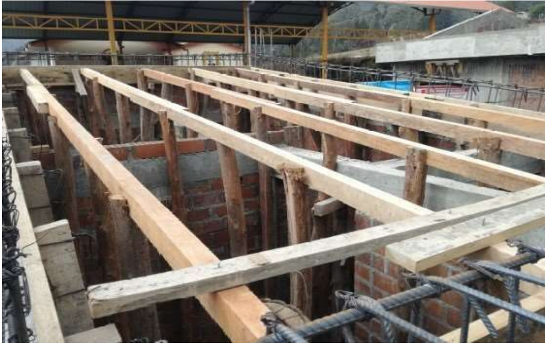
Figura 55 — Encofrado de losa aligerada del bloque I
