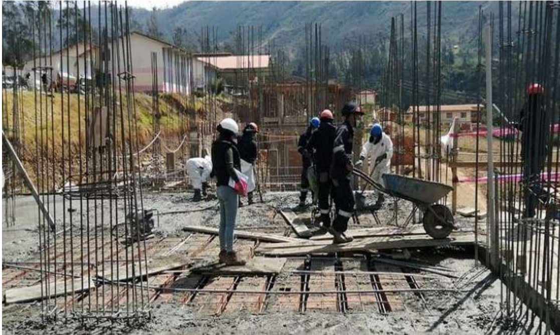
Figura 65 — Personal obrero ejecutando el vaciado de losa aligerada del bloque IV, con supervisión del personal técnico
