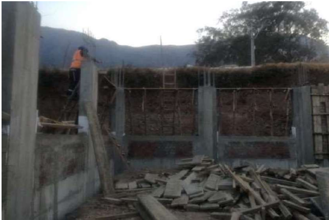
Figura 53 — Personal obrero realizando el encofrado de vigas del bloque I
