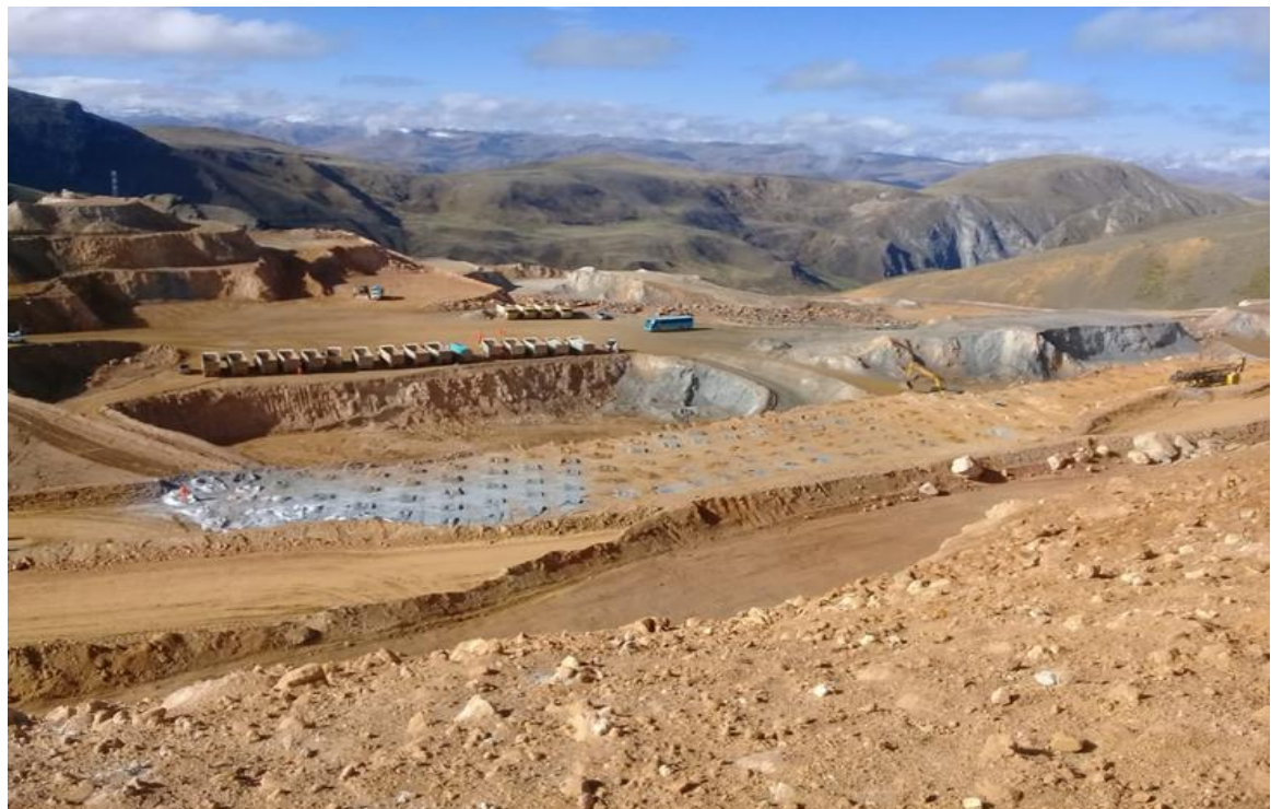
Figura 45 — Proyecto de voladura
