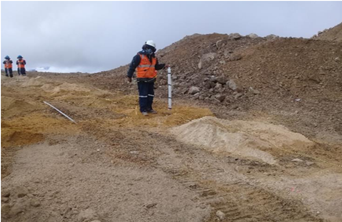
Figura 48 — Proceso de carguío de taladro
