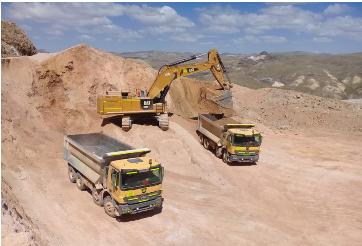
Figura 51 — Carguío de mineral Excavadora 390
