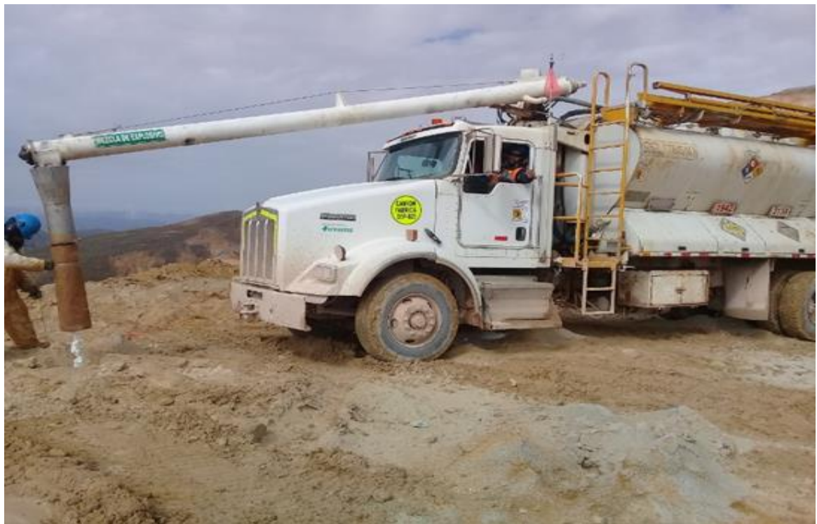
Figura 49 — Proceso de carguío de taladros con camión fabrica
