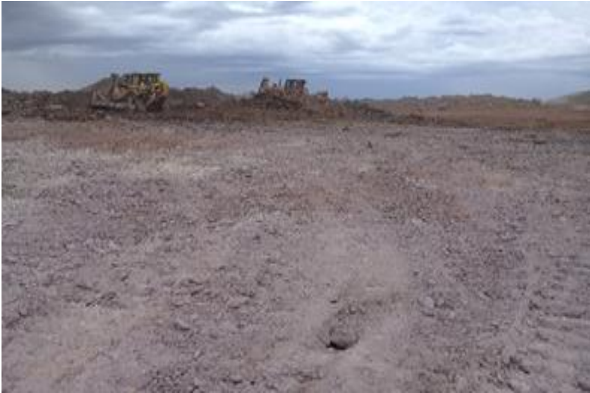
Figura 42 — Limpieza de Plataforma de Perforación BC 4656
