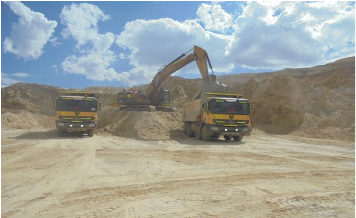
Figura 52 — Carguío de mineral Excavadora 345
