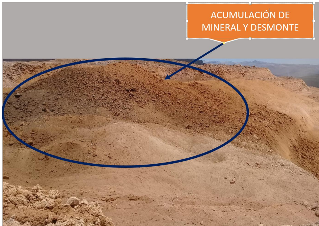
Figura 24 — Vista del proyecto después de voladura
