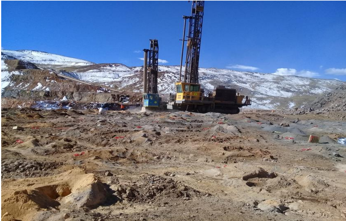
Figura 44 — Perforación con DM-45
