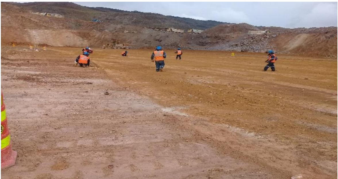
Figura 43 — Armado de malla de perforación
