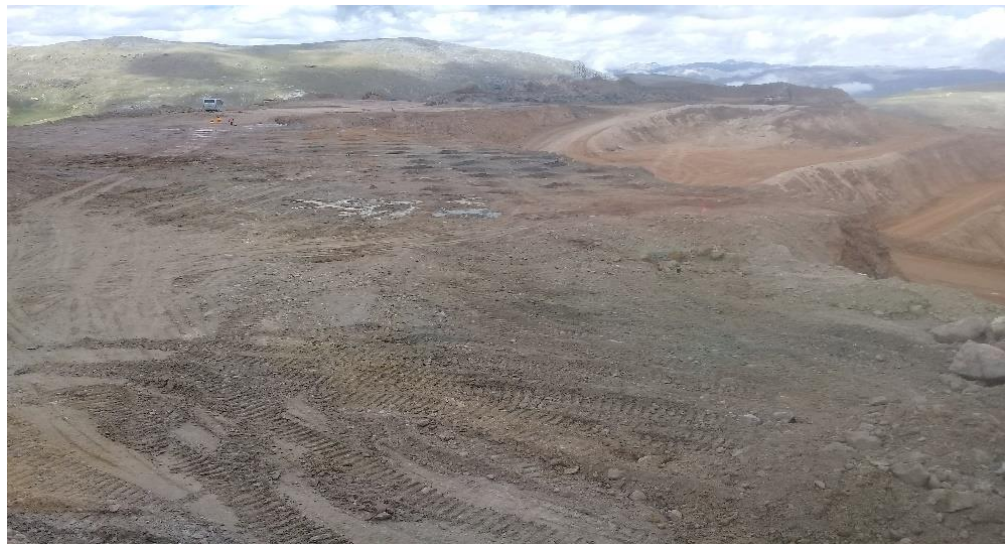
Figura 30 — Proyecto de voladura banco 4648 py 33
