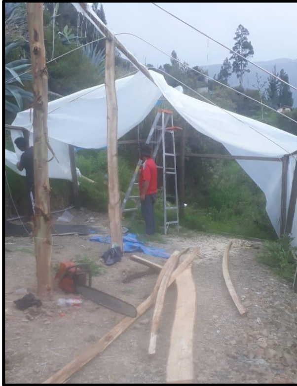
Figura 8 — Instalación del invernadero experimental en el sector de Kiskapukro
