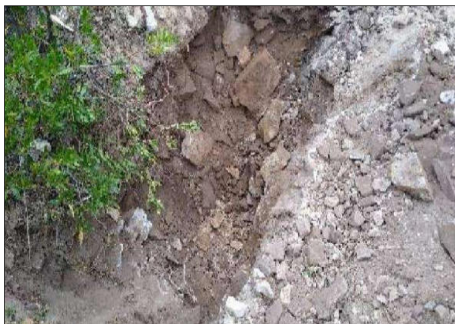
Figura 5 — Vista de la Calicata C - 03
