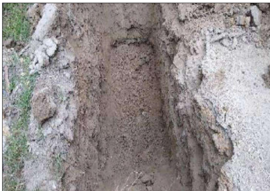
Figura 11 — Vista de la Calicata C – 09
