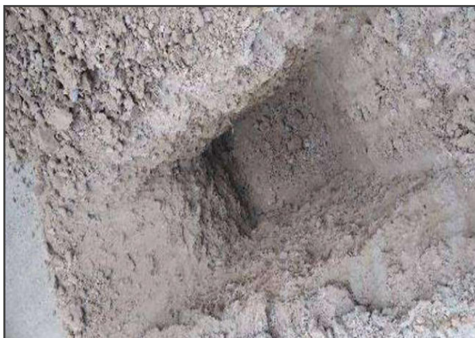
Figura 3 — Vista de la Calicata C – 01
