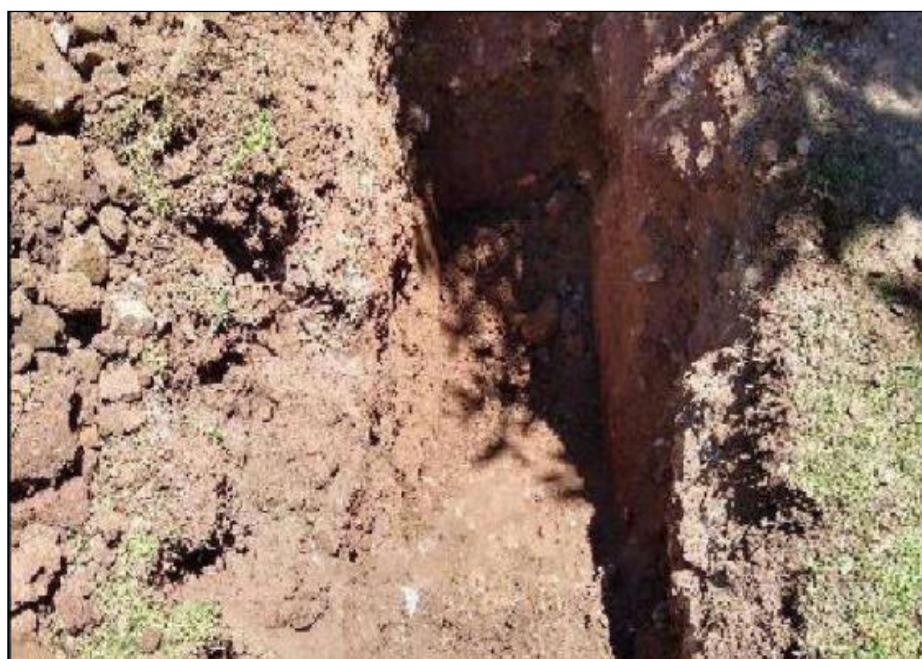
Figura 10 — Vista de la Calicata C - 08
