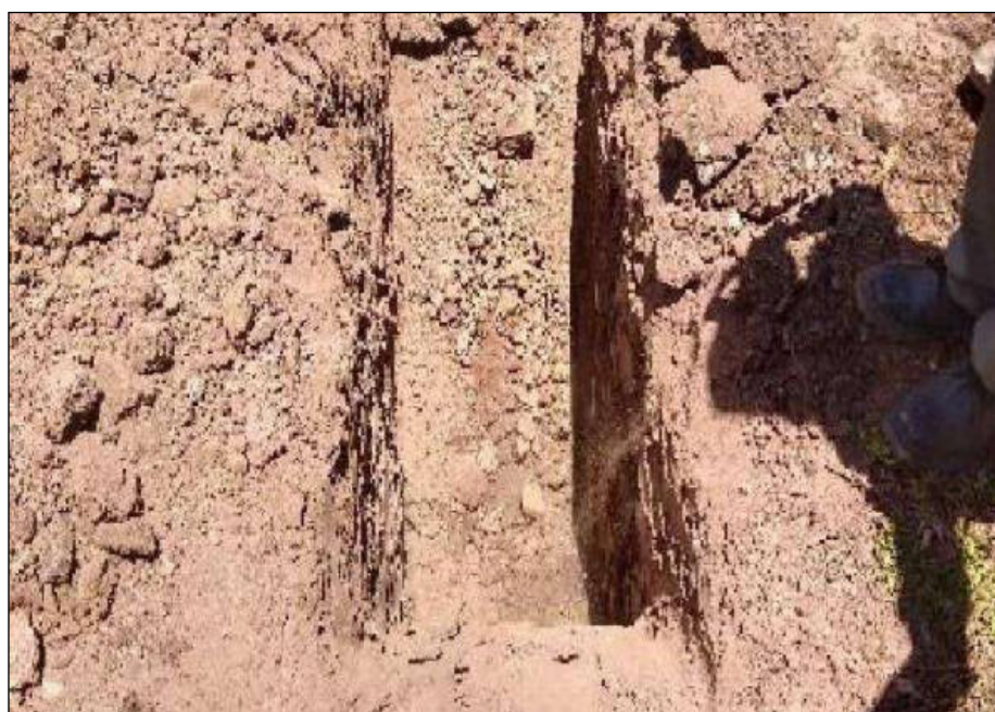
Figura 7 — Vista de la Calicata C – 05
