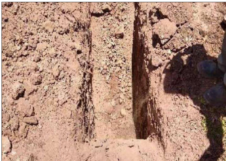
Figura 6 — Vista de la Calicata C – 04
