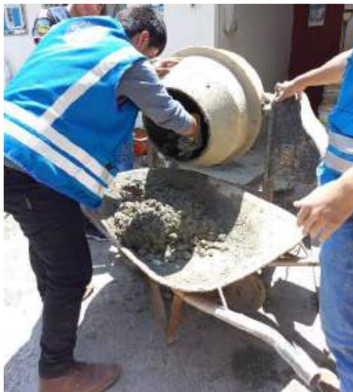
**Figura 11 – Elaboración concreto según diseño de mezcla.**
