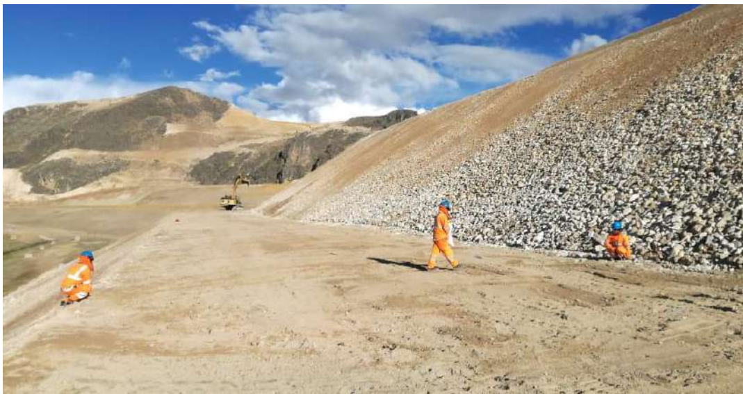
Figura 51 — Plantillado de banquetas método tradicional
