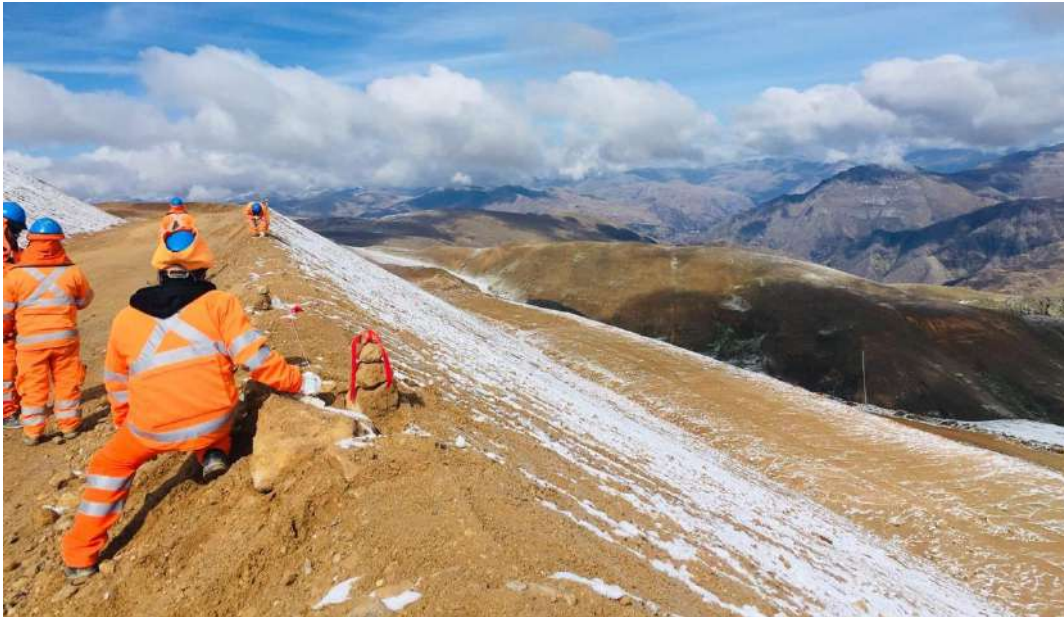
Figura 50 — Plantillado de taludes método tradicional
