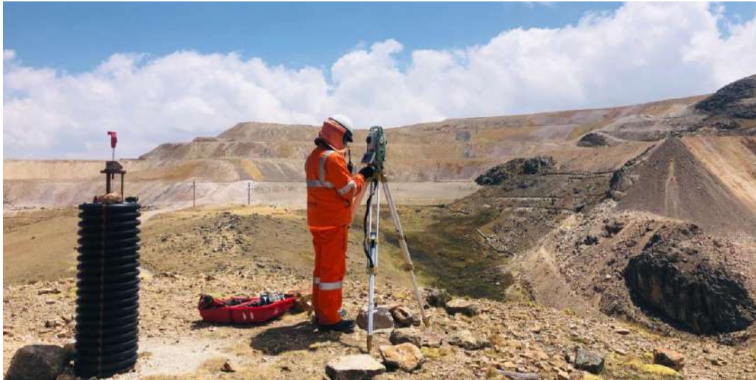
Figura 52 — Trazo y replanteo con estación total método civil 3D
