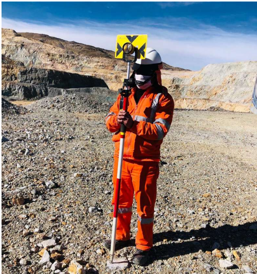
Figura 53 — Trazo y replanteo con estación total método civil 3D
