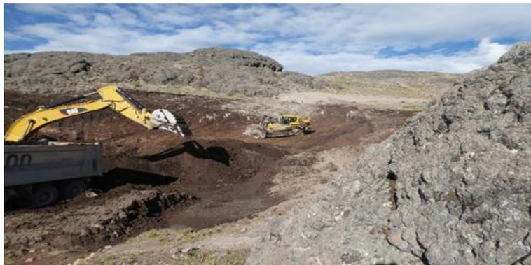
**Figura 10 — Corte de material orgánico (Top Soil) para eliminación**
