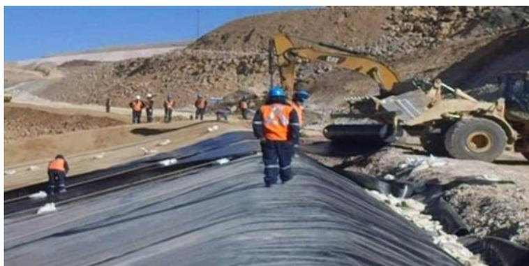
**Figura 22 — Colocación de geomembrana**
