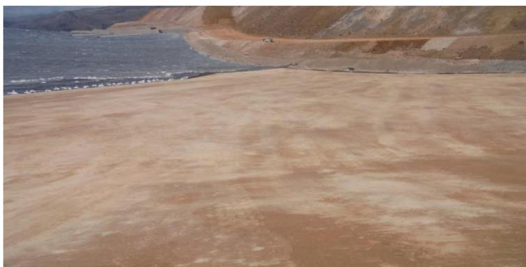
**Figura 21 — Liberación capa de relleno de baja permeabilidad**
