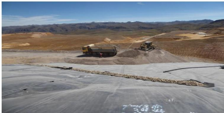
**Figura 26 — Extendido de overliner sobre revestimiento de geomembrana**
