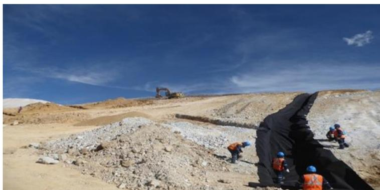
**Figura 12 — Excavación para sub-drenaje**
