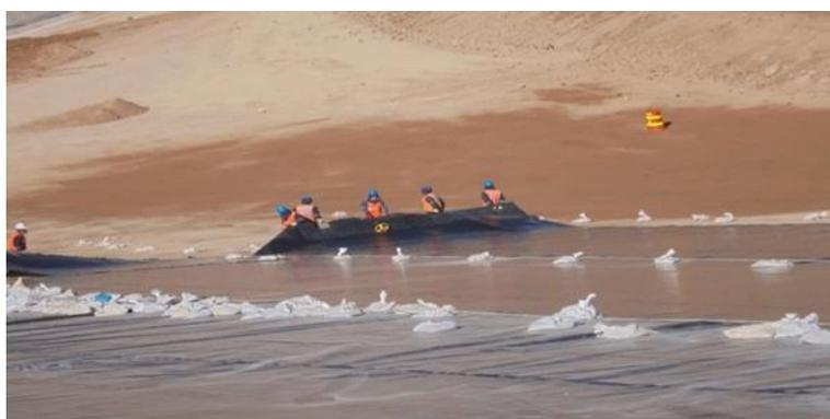
**Figura 23 — Despliegue de geomembrana**
