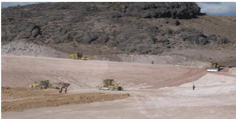
**Figura 14 — Colocación de material clasificado para relleno estructural**
