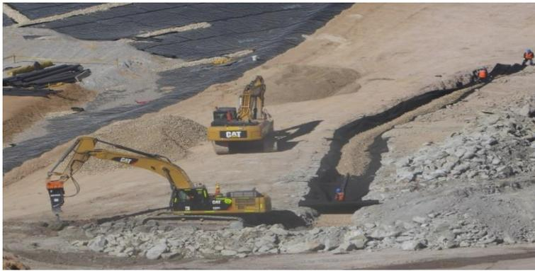
**Figura 13 — Instalación de geotextil de 270 g/m<sup>2</sup>, instalación de tubería perforada CPT-HDPE de pared doble y colocación de grava de drenaje en sub-drenaje.**
