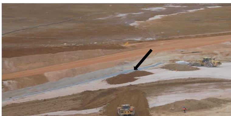
**Figura 18 — Preparado y descubierto del material de baja permeabilidad y geomembrana para el correcto traslape entre las fases**
