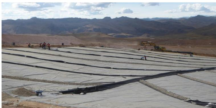
**Figura 24 — Instalación de geotextil de 270 g/m<sup>2</sup>, instalación de tubería perforada CPT-HDPE de pared doble y colocación de grava para drenaje de solución lixiviada**
