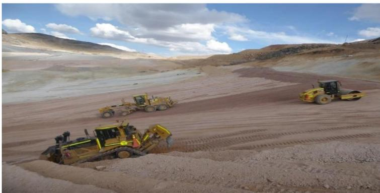
**Figura 15 — Nivelación y compactación de sub-rasante**
