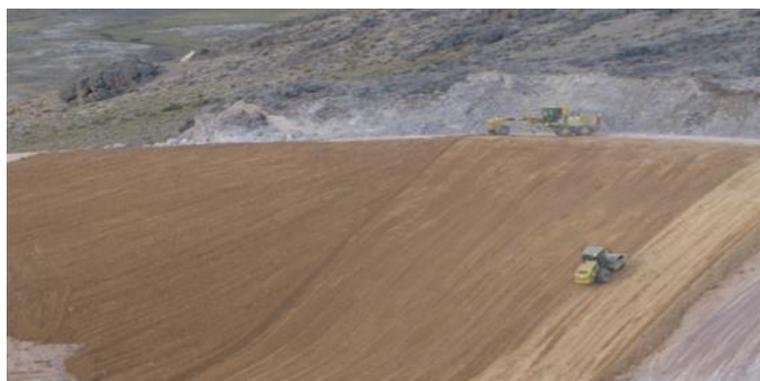
**Figura 16 — Conformación de capa impermeable (clay)  $e=30\text{cm}$**
