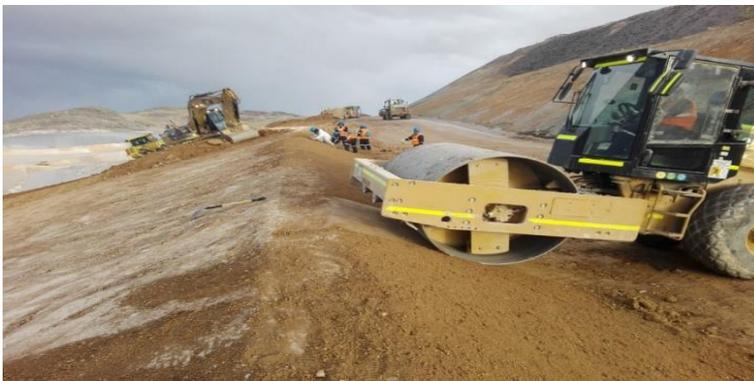
**Figura 20 — Conformación de berma perimetral**
