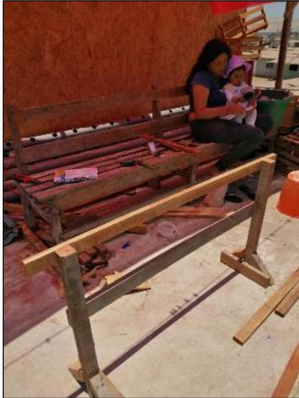
Figura 43 — Construcción de soporte para tubos que transportaran solución nutritiva
