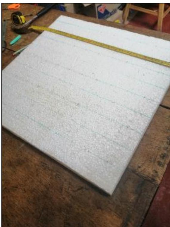
Figura 51 — Marcado de tecnopor para realizar agujeros y acoplamiento con módulos de post almacigo
