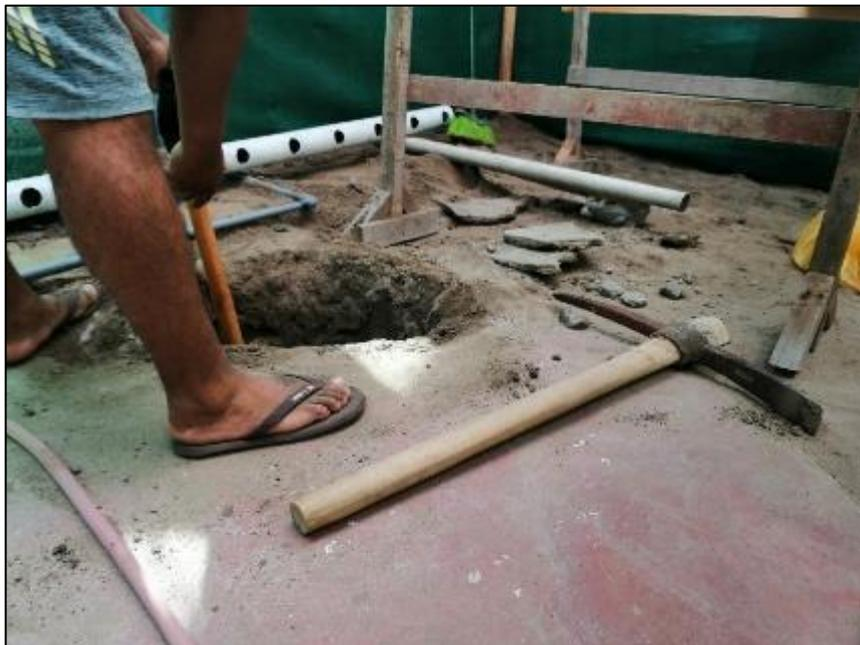
Figura 44 — Escarbando orificio para colocar tacho que contendrá solución nutritiva
