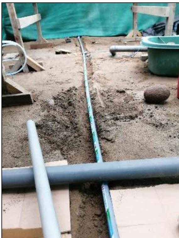
Figura 47 — Instalación red de agua
