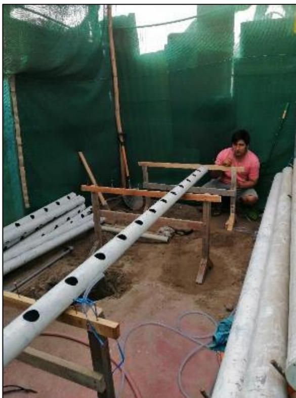
Figura 45 — Nivelación de soportes para las tuberías
