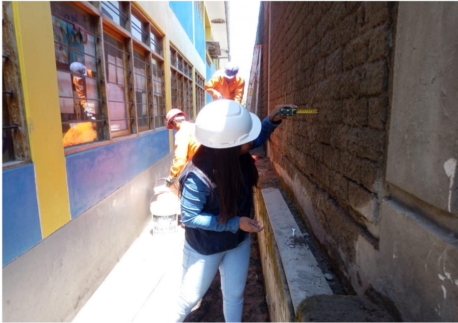
Figura 48 — Verificación del espesor del mortero 1.5 cm
