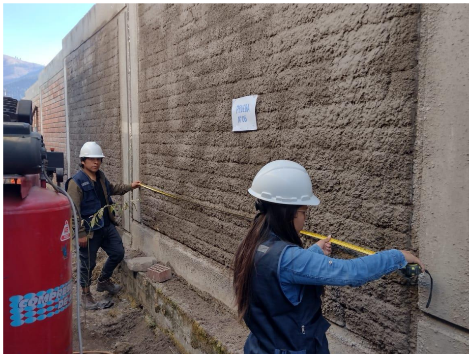
Figura 45 — Medida del área pañeteada N°06
