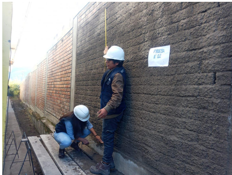
Figura 41 — Medida del área pañeteada N°02
