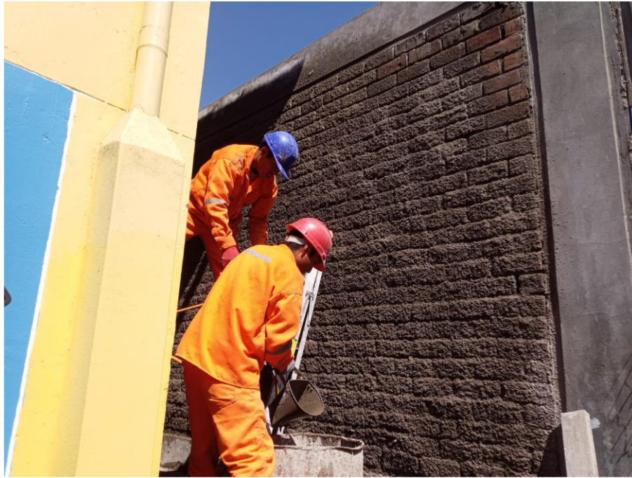
Figura 42 — Procedimiento del pañeteo del área N° 03
