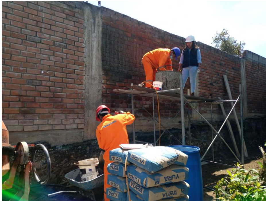
Figura 50 — Proceso de pañeteo con revocadora y andamio
