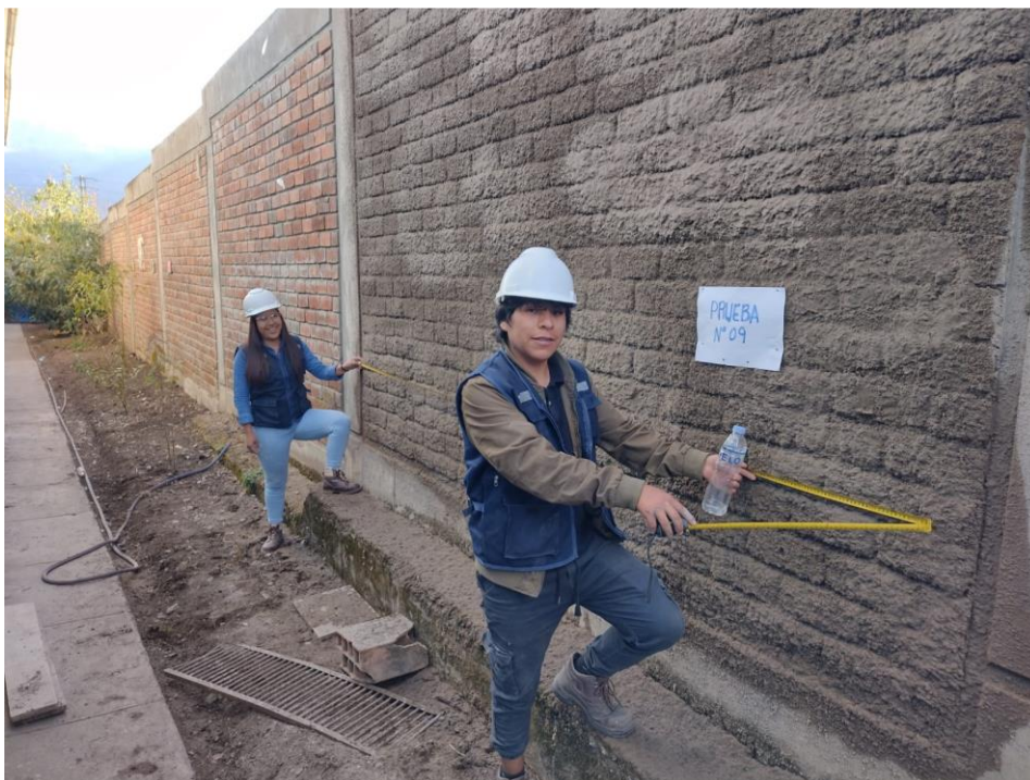
Figura 47 — Medida del área pañeteada N°09
