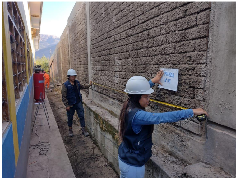
Figura 43 — Medida del área pañeteada N°04
