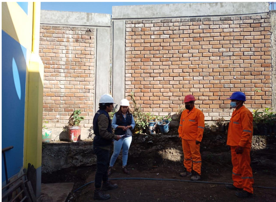
Figura 49 — Charla previa a los trabajos
