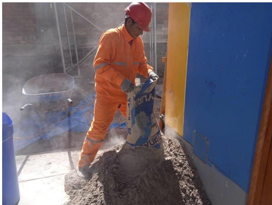
Figura 39 — Personal obrero realizando la mezcla de los materiales para el mortero
