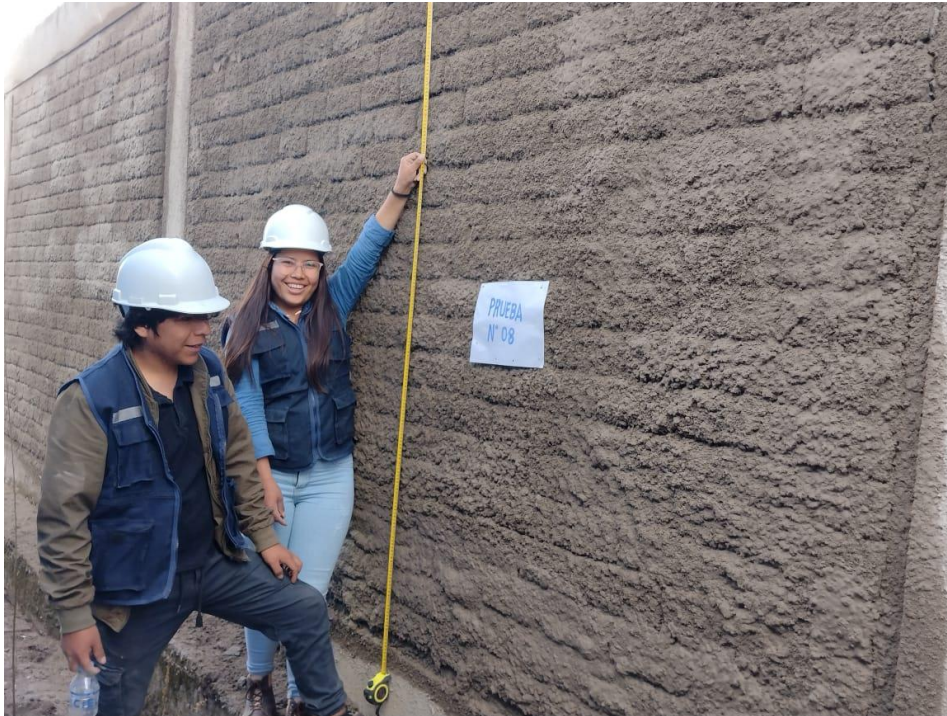
Figura 46 — Medida del área pañeteada N°08
