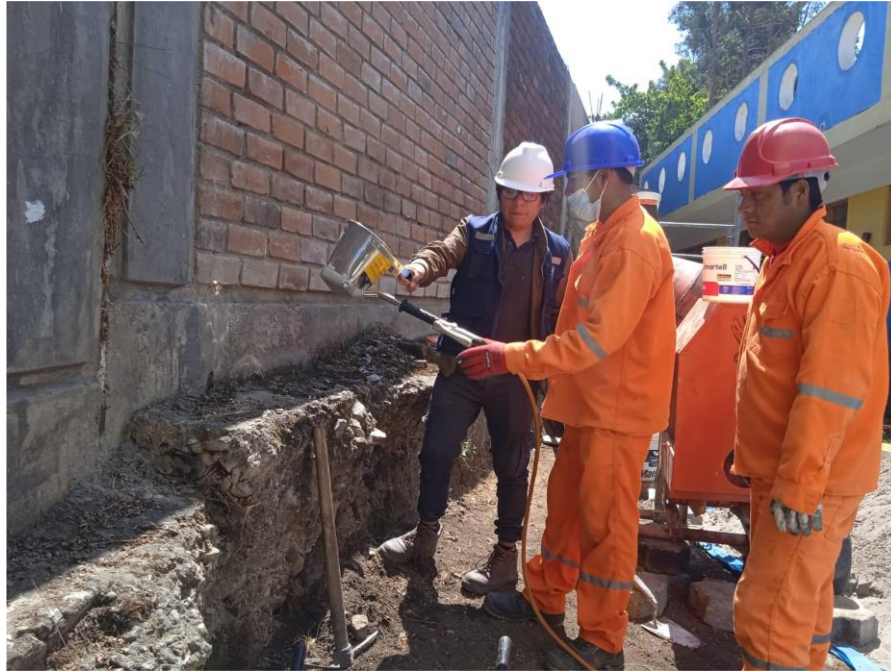
Figura 38 — Capacitación sobre el funcionamiento de la revocadora
