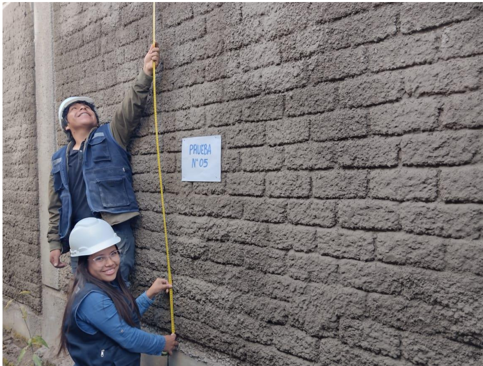
Figura 44 — Medida del área pañeteada N°05
