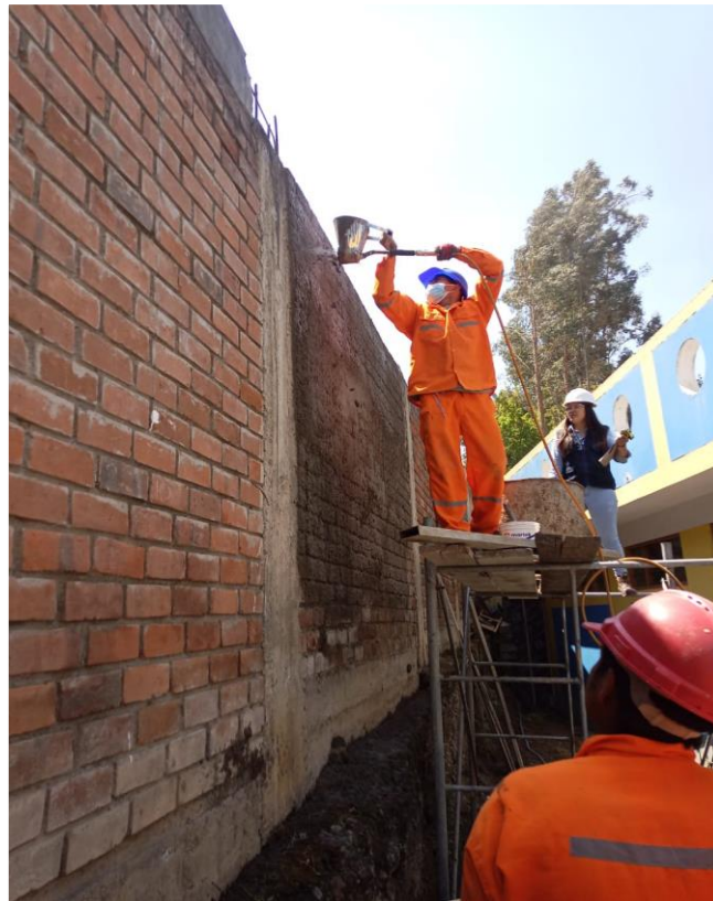
Figura 40 — Procedimiento del pañeteo del área N° 01
