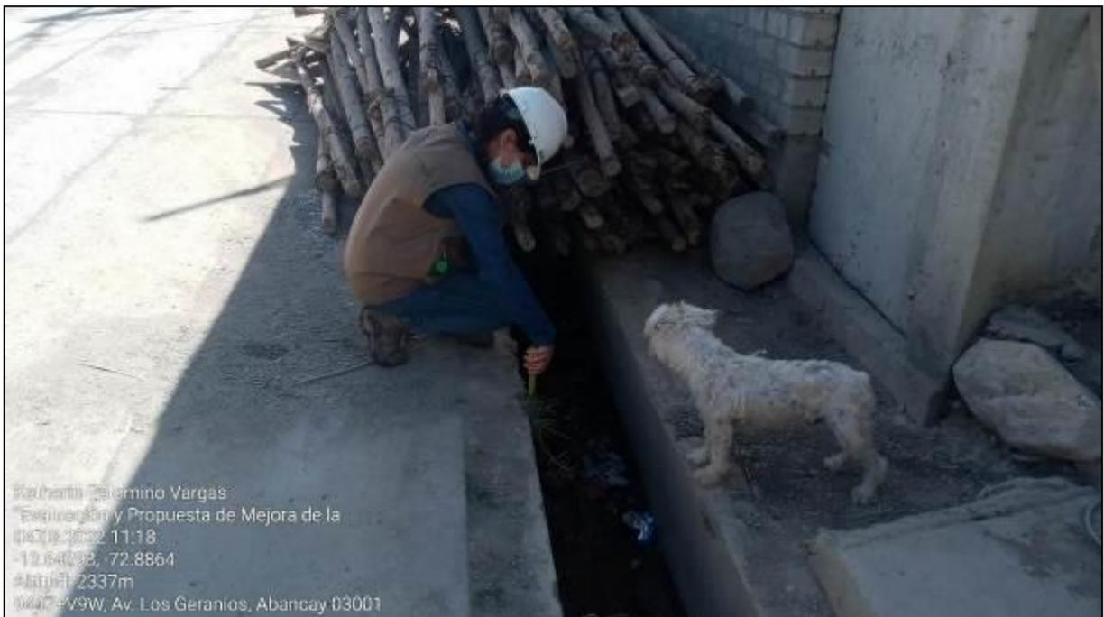
**Figura 34 — Drenaje Pluvial con exceso de desechos y escombros, todo ello afecta a que el agua transcurra de manera correcta.**
