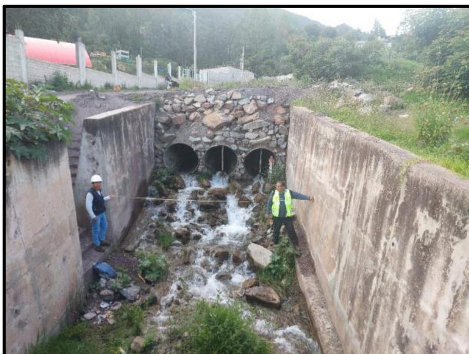
**Figura 90 — Tramo de obra de drenaje y protección a 1200 m del inicio (aguas abajo) toma de datos de las dimensiones de la gemetría del canal.**
