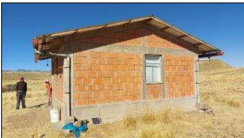
**Figura 100 — Módulo habitacional con muros de ladrillo con EPS 2-2**
