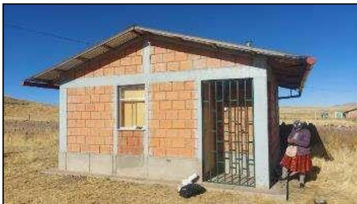
**Figura 98 — Módulo habitacional con muros de ladrillo con EPS 2-1**
