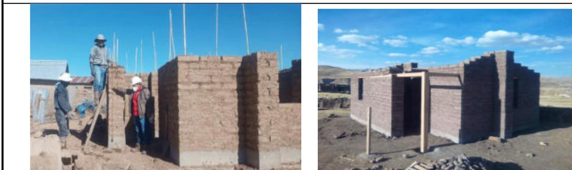
En la fotografía se muestra la visita a la obra para verificar el asentado de adobe y su culminación de muro de adobe reforzado. Se verifica la viga collar y su aseguramiento.
