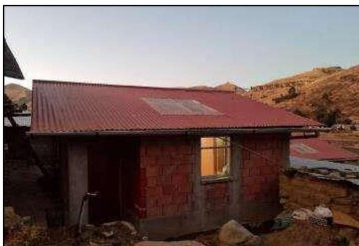
Figura 108 — Módulo habitacional con muros de ladrillo con EPS 3-3
