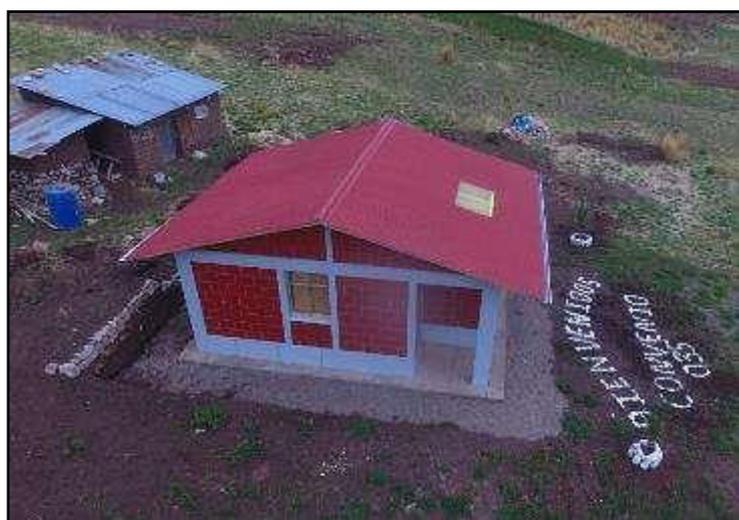
**Figura 4 — Vivienda Rural Sumaq Wasi de doble muro de ladrillo con EPS**
