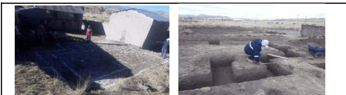
En la fotografía se muestra la visita a campo para ver trazo - replanteo y excavación para cimentación
