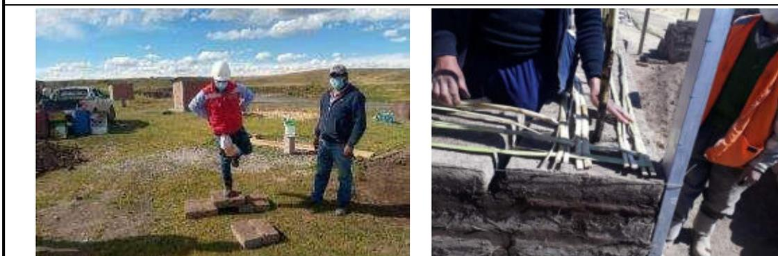
En la fotografía se muestra la visita a la obra para ver el control de calidad de adobe y refuerzo horizontal con caña chancada en el muro.
