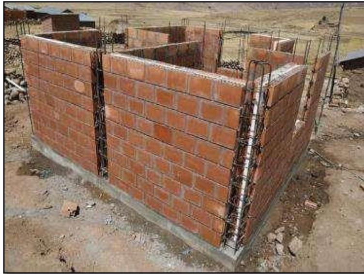
**Figura 5 — Muro estructural de doble muro de ladrillo con EPS**
