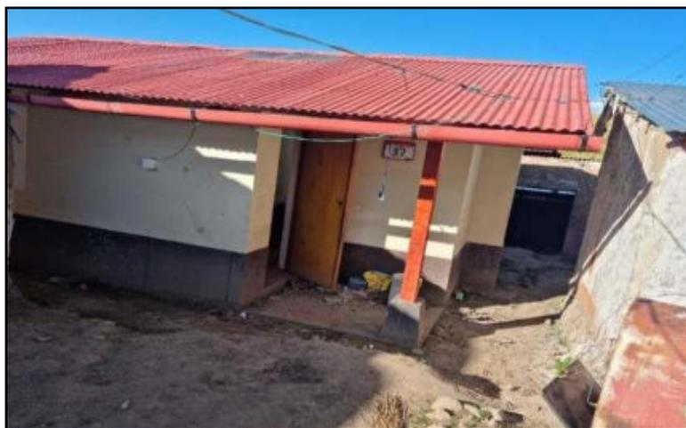
**Figura 66 — Módulo habitacional con muros de adobe reforzado con caña 1-1**
