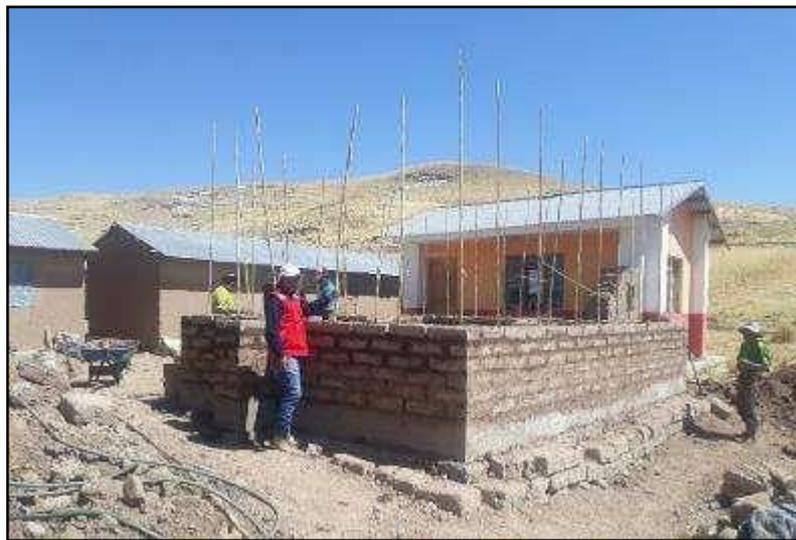
**Figura 3 — Muro de adobe reforzado con carrizo horizontal y vertical**
