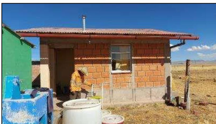
**Figura 102 — Módulo habitacional con muros de ladrillo con EPS 2-3**
