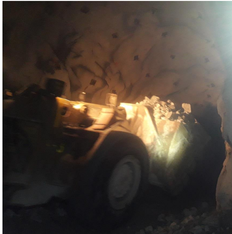
Figura 57 — Limpieza y carguío de desmonte con scoop
