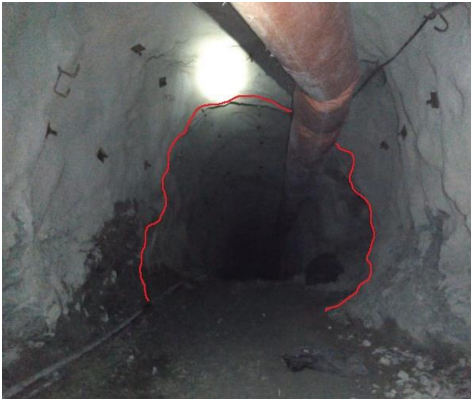
Figura 47 — Bypass 2843 con irregularidades en los hastiales y corona antes del estudio
