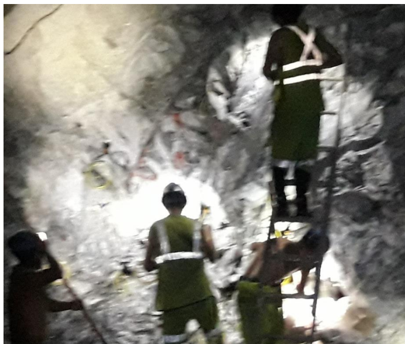
Figura 54 — Carguío de los taladros del frente
