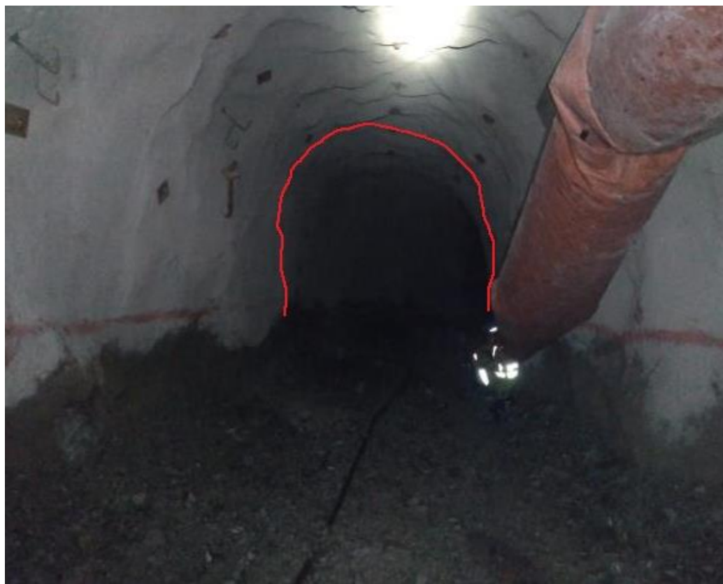
Figura 60 — Bypass 2843 ejecutado con voladura de recorte
