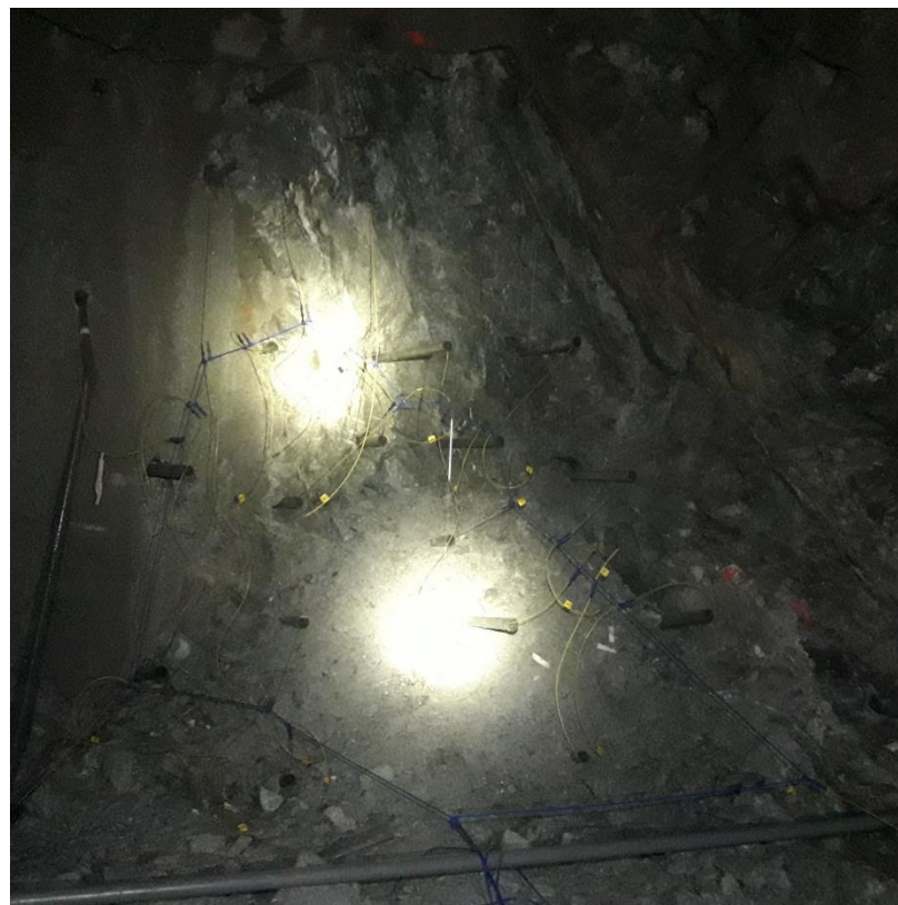
Figura 56 — Distribución de Exsanel y cordón detonante en el frente
