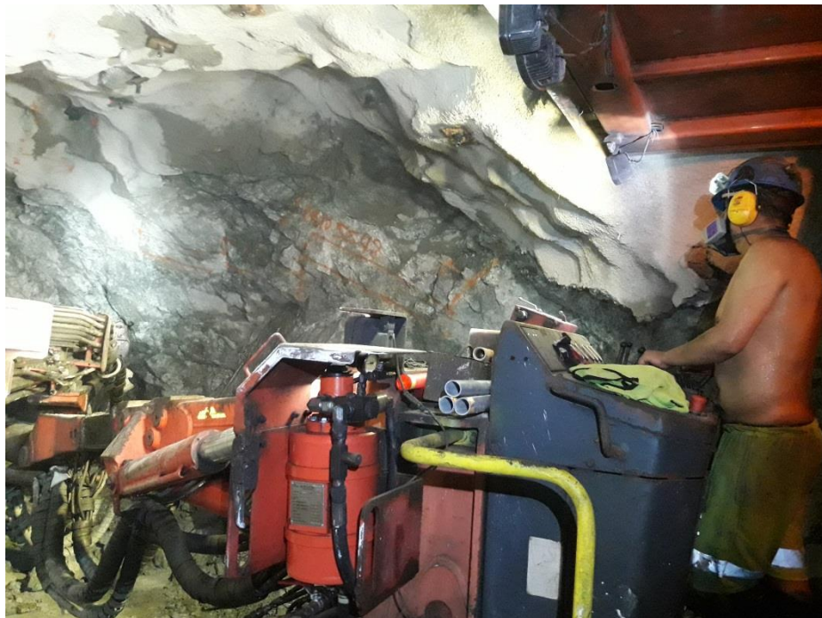
Figura 48 — Contorno irregular del bypass 2843 antes del estudio
