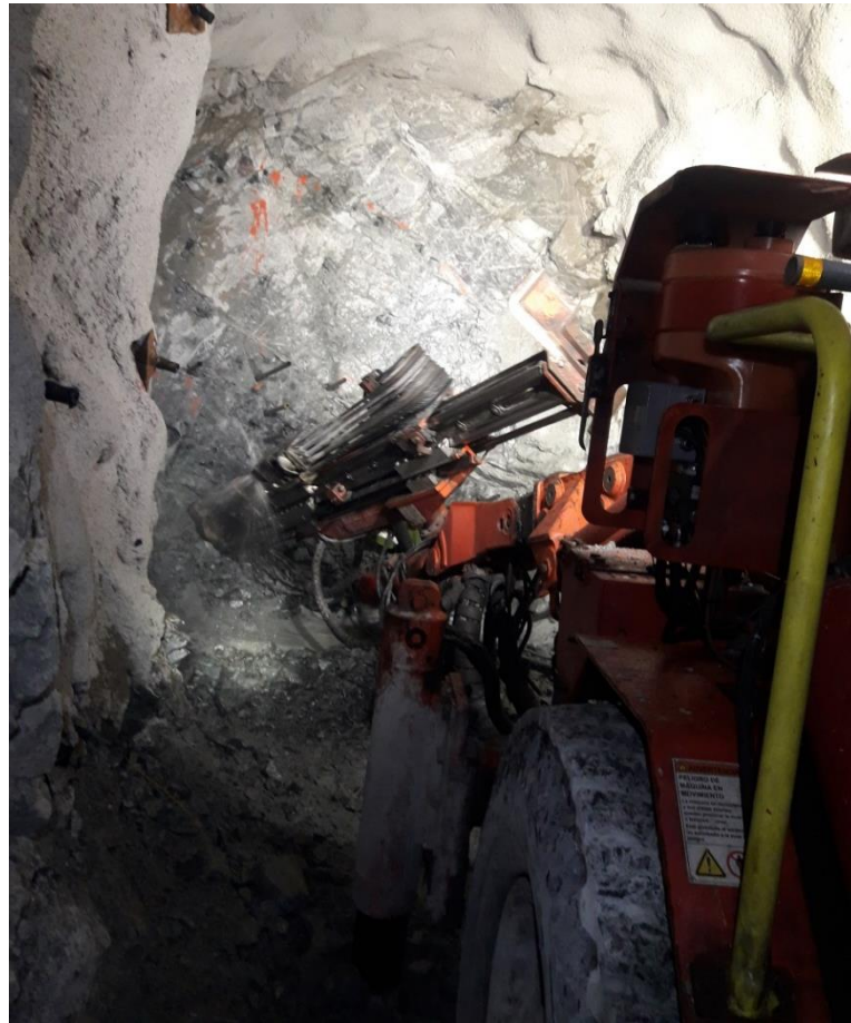
Figura 53 — Perforación con Jumbo DD311
