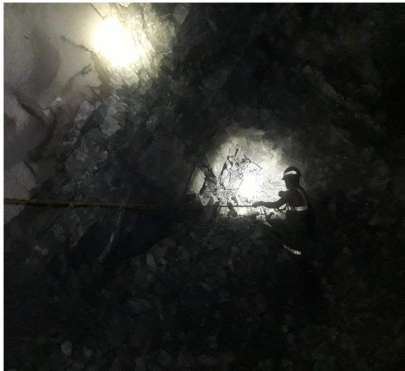
Figura 58 — Control del avance por disparo
