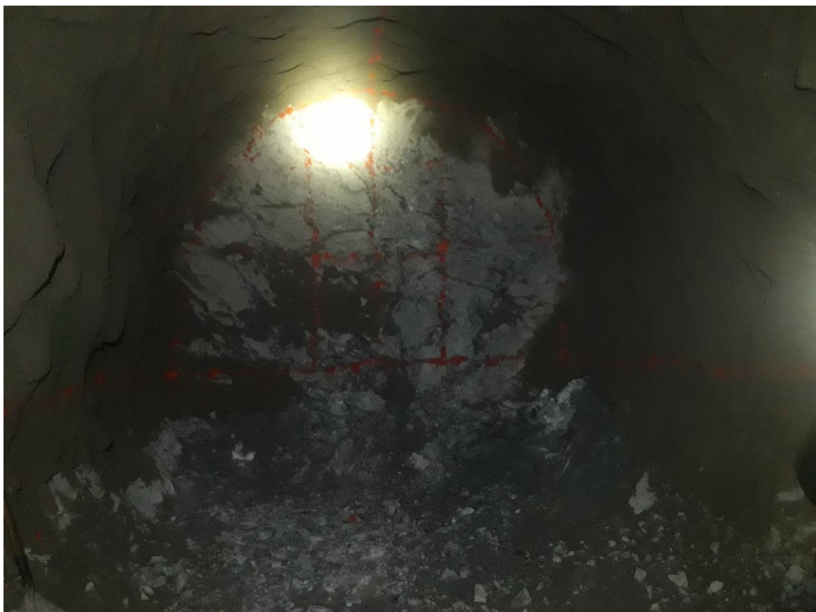
Figura 52 — Pintado y trazado de malla de perforación
