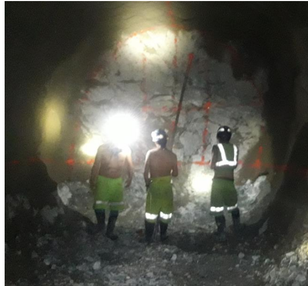
Figura 51 — Pintado y trazado de malla de perforación
