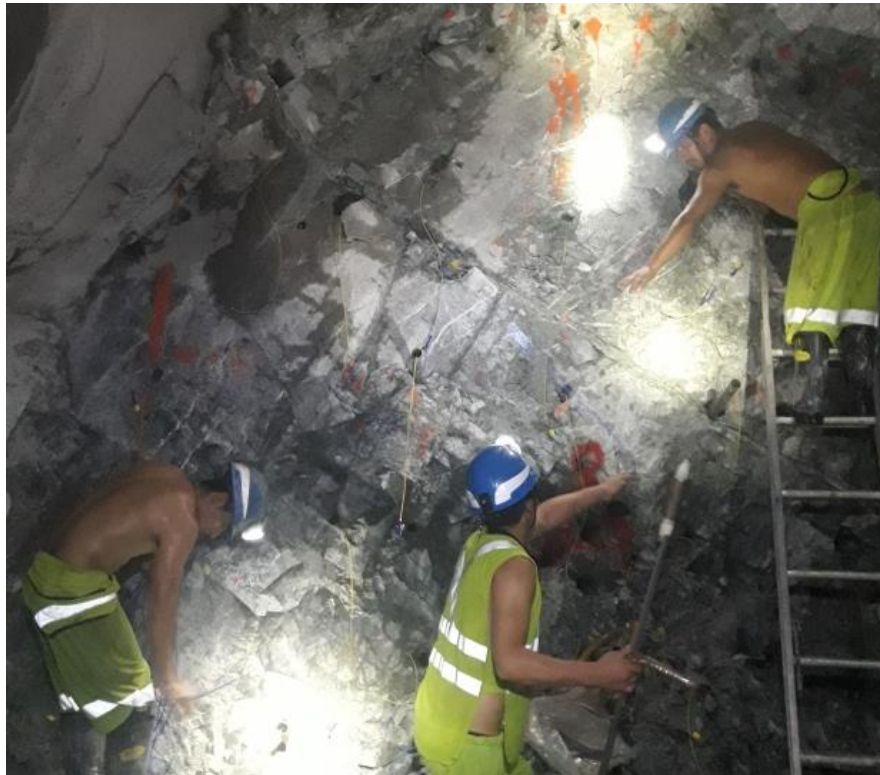
Figura 55 — Carguío de los taladros del frente
