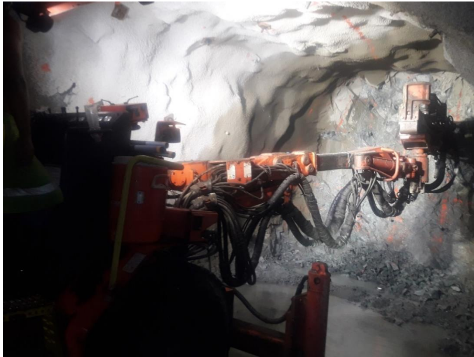
Figura 59 — Paredes más regulares del bypass 2843 después de la voladura de recorte
