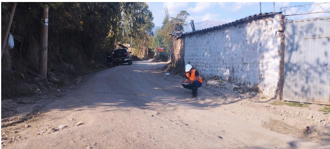
Figura 72 — Registro del inicio de la vía
