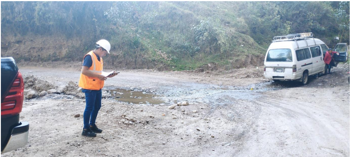
Figura 74 — Registro de punto notable bajada de agua
