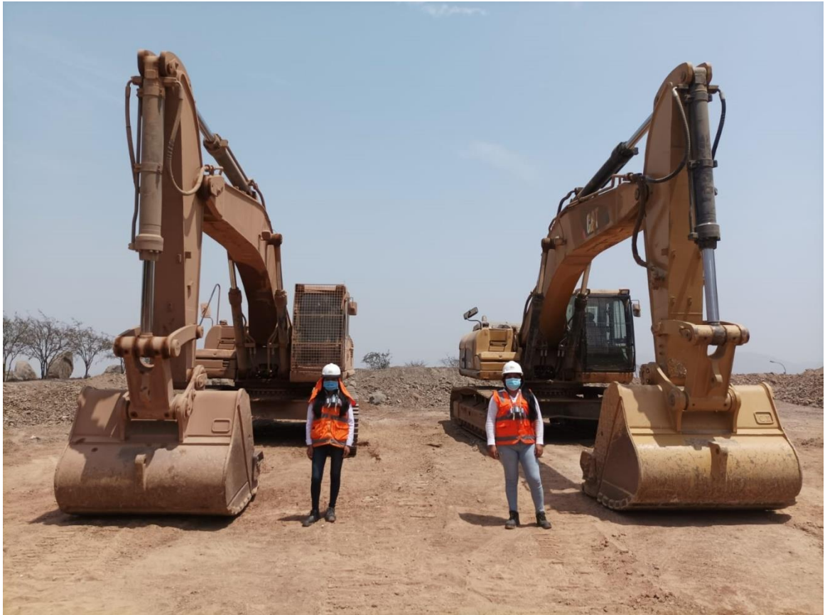
Figura 26 — Zona de parqueo de excavadores destinadas para el carguío de material
