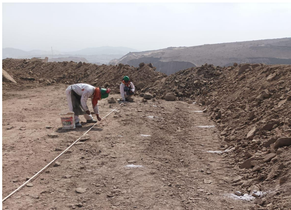
Figura 12 — Malla de perforación del Tajo Fiorella 508
