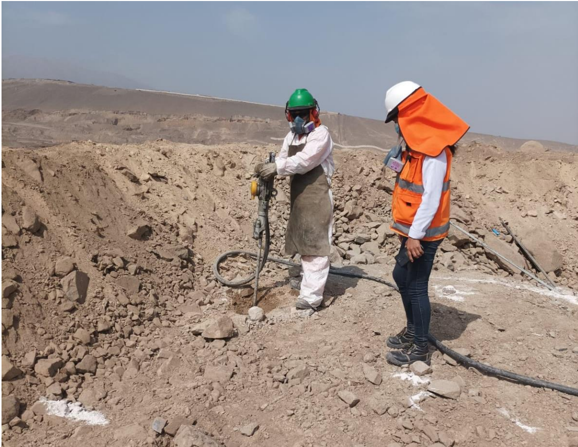
Figura 28 — Perforación de taladros
