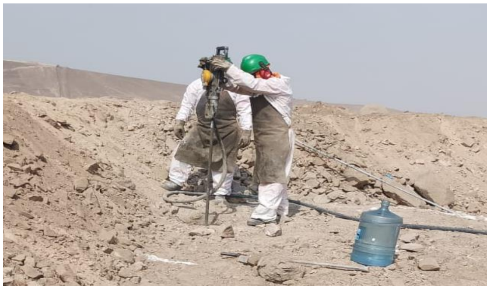
Figura 5 — Realizando la perforación en el tajo de la U.P. Fiorella 508 Extraído de la U.P. Fiorella 508
