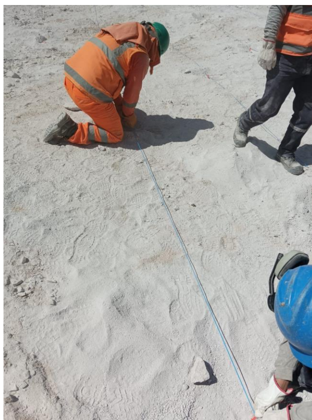
Figura 31 — Secuencia de amarre de voladura
