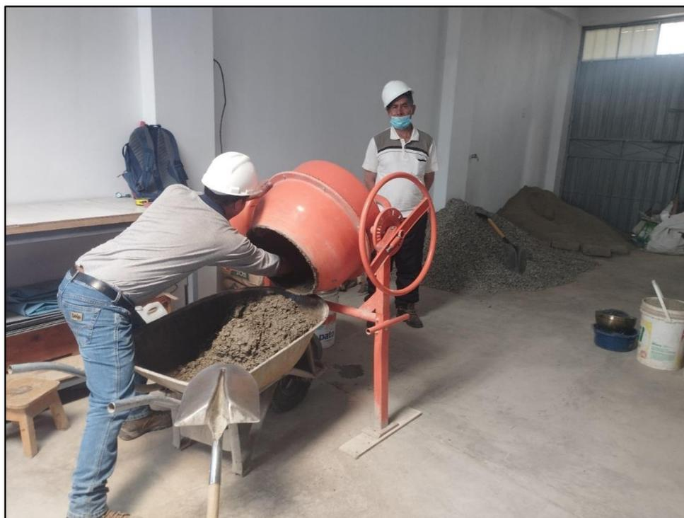
Figura 47 — Extracción de la mezcla de concreto
