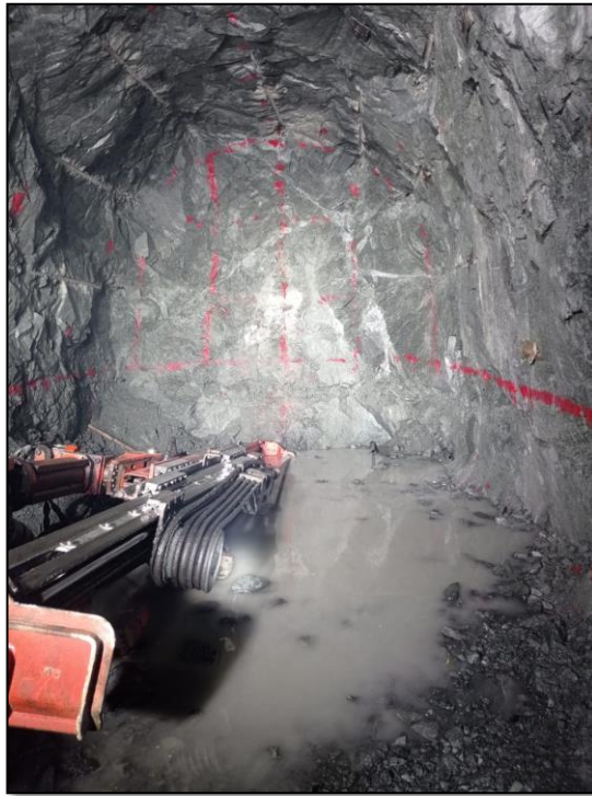
Figura 14 — Figura pintado de frente para perforación de la Rampa 100
