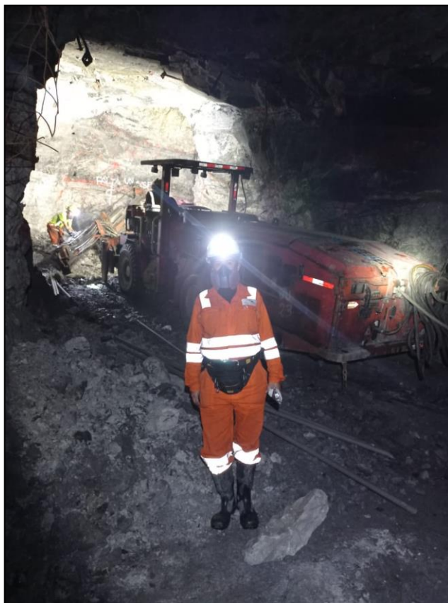
Figura 16 — Elfie Córdova observando la actividad de Perforación Rampa 100
