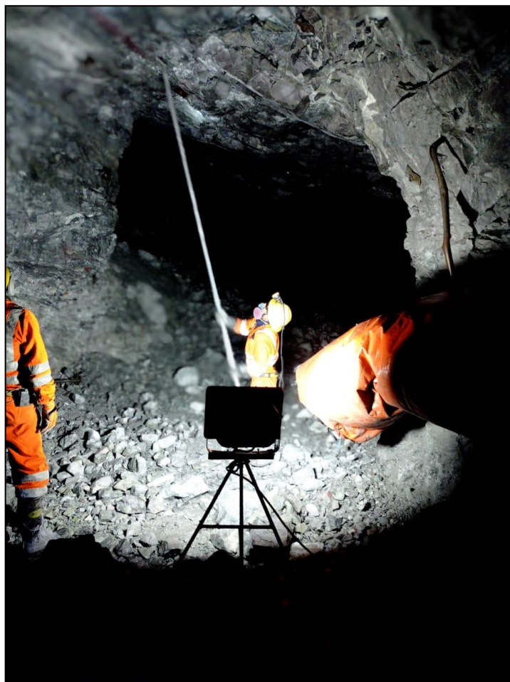
Figura 20 — Desatado de rocas después de realizar la actividad de voladura en la Rampa 100
