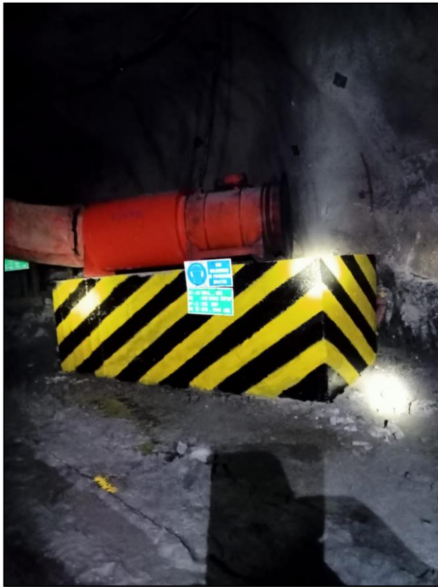
Figura 18 — Equipo ventilador ubicado en la Rp 100
