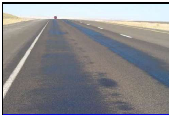
Figura 5 – Mancha en Pavimentos (exudación).
