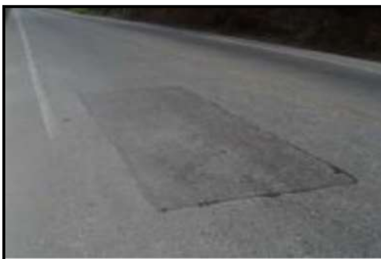
Figura 26 – Parches para deterioros.
