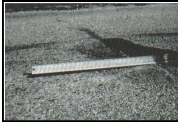
Figura 10 — Nivel de Severidad Bajo de Abultamiento y Hundimiento en el Pavimento.
