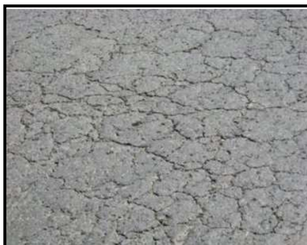
Figura 3 – Nivel de gravedad Medio de piel de cocodrilo.
