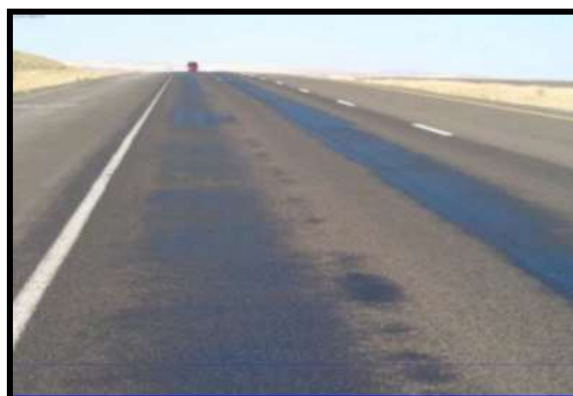
Figura 7 — Nivel de gravedad continua.
