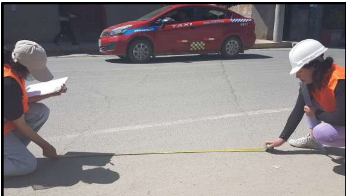
Figura 93— Grietas longitudinal y transversal/ AV. LEONCIO PRADO KM 0+177 AL KM 0+212.40
