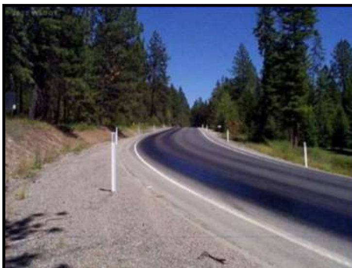
Figura 8 – Nivel de gravedad continua con superficie viscosa.
