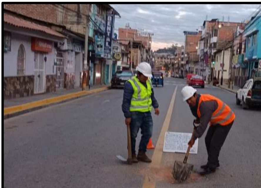
Figura 57 — Excavación de la calicata N° 01
