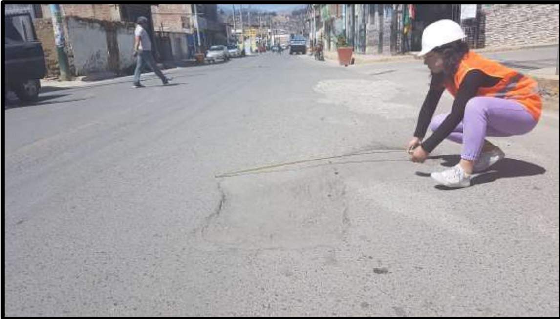
Figura 94 — Ahuellamiento de severidad Media / Tramo 04 / AV. LEONCIO PRADO KM 0+531 AL KM 0+566
