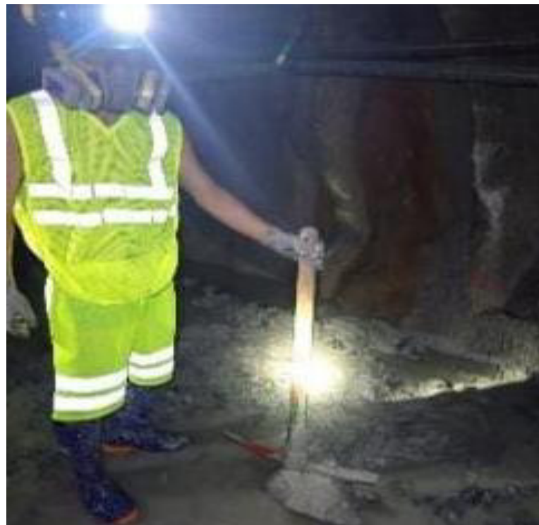
Figura 29 — Vista de personal realizando trabajos de cantoneo
