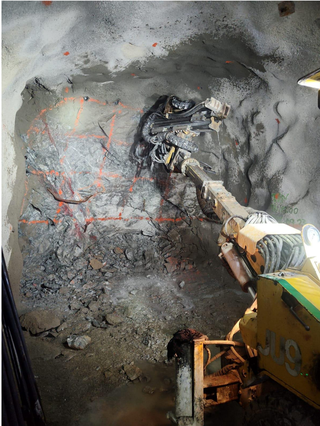
Figura 23 — Pintado de malla e inicio de perforación del frente de voladura
