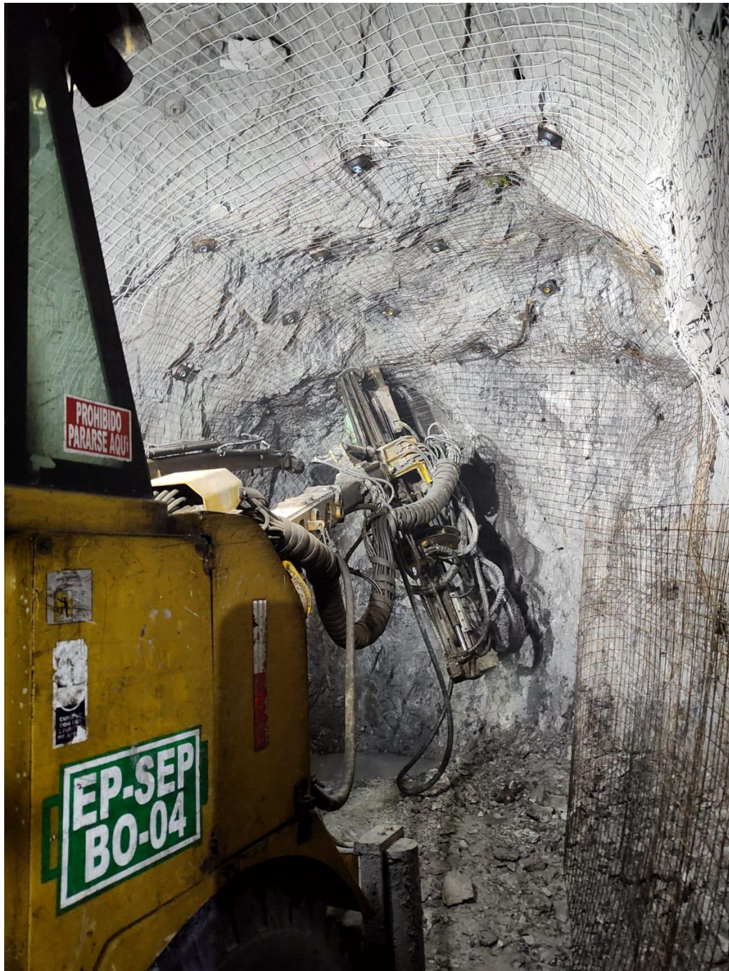
Figura 24 — Sostenimiento del frente de voladura
