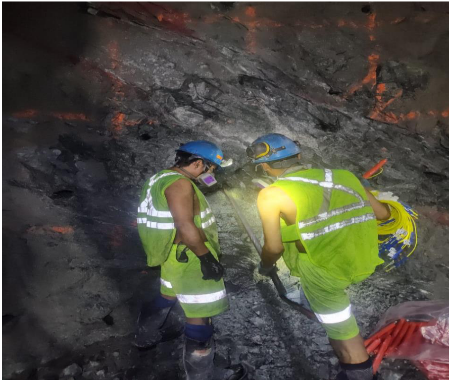
Figura 19 — Carguío de taladros con explosivos Emulsión
