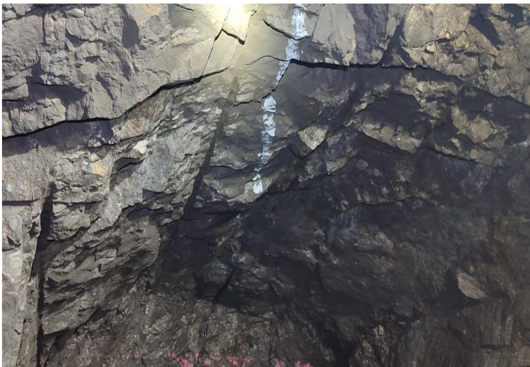
Figura 22 — Resultado de voladura con ANFO (optimo)
