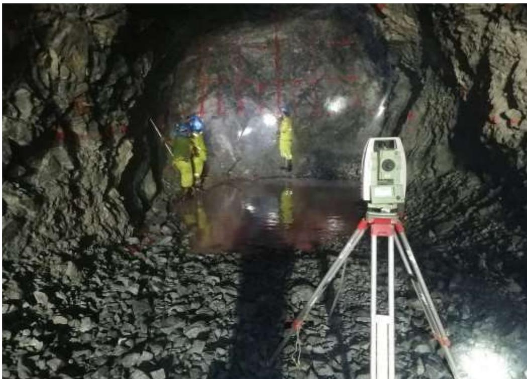
**Figura 16 — Control topográfico en la ejecución de la rampa**
