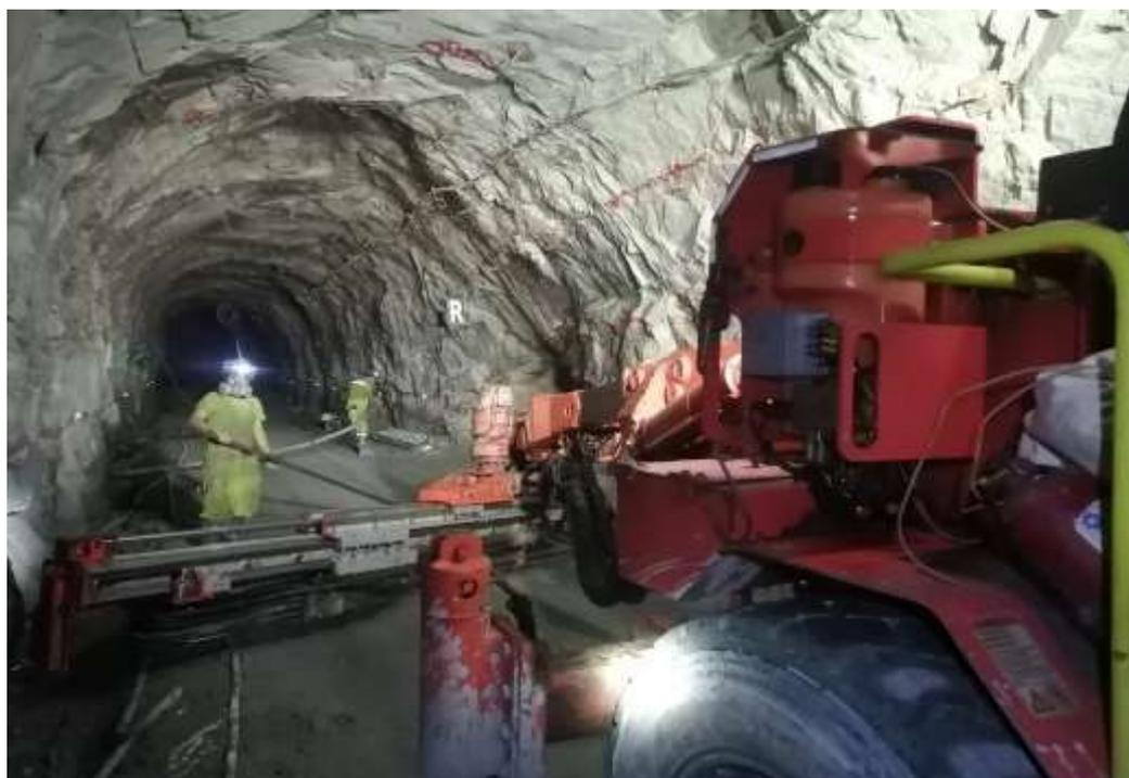
**Figura 17 — Control topográfico y geométrico de la rampa en la ejecución de la rampa**
