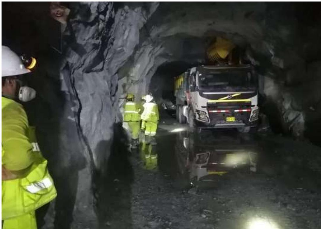
**Figura 14 — Ejecución de la rampa se observa la sección de la rampa**
