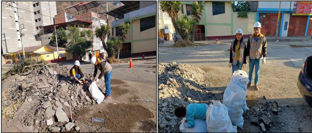
Figura 127 — Reciclaje de pavimento asfáltico en la Av. Pachacútec
