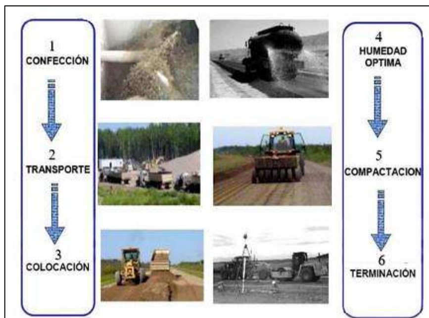
Figura 3 — Etapas para la preparación de la base
