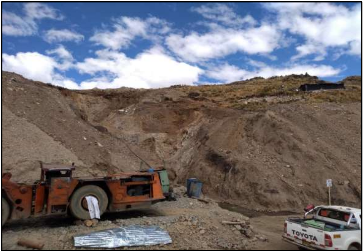
Figura 64 — Vista panorámica de la mina
