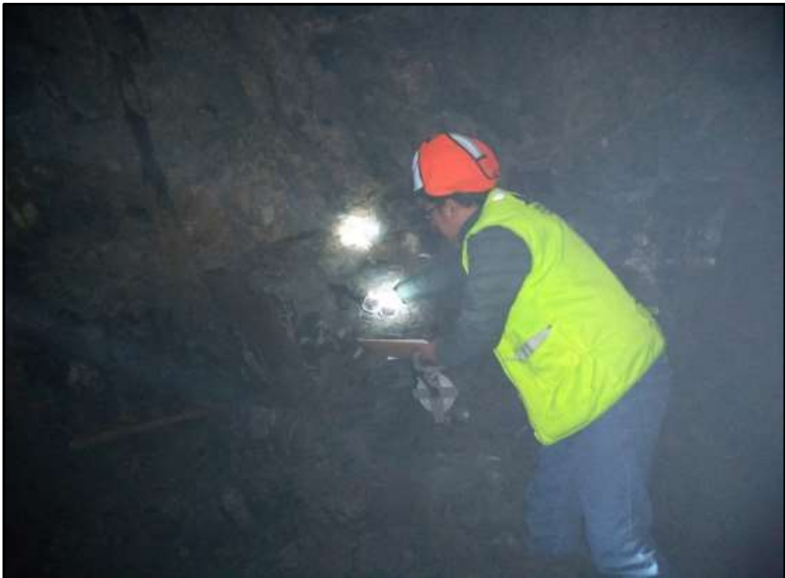
Figura 66 — Mapeo geomecánico en interior mina de la galería nivel 4040
