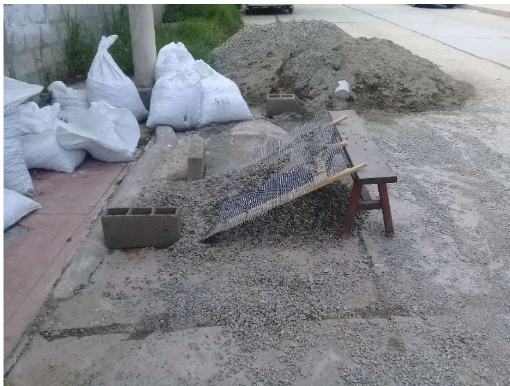
Figura 48 — Tamizado del agregado
