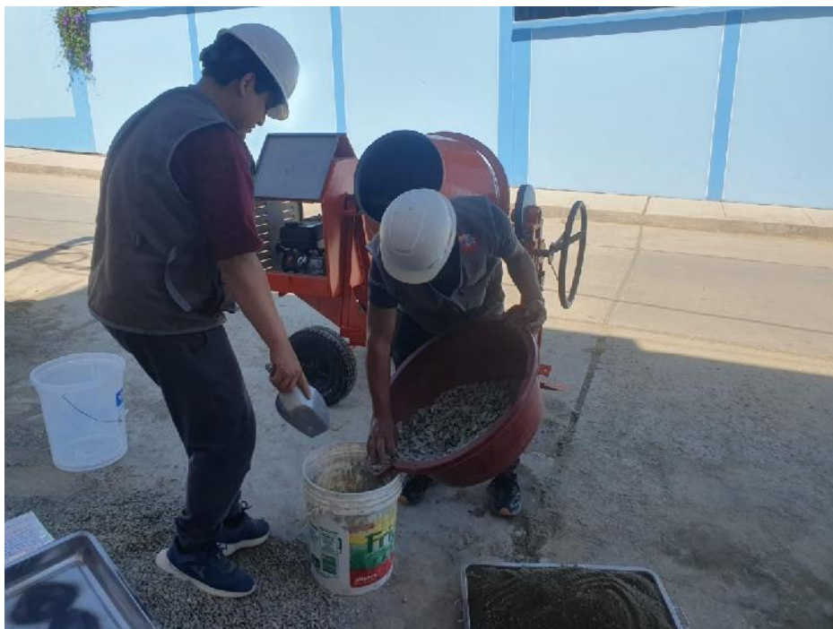
Figura 104 — Vaciado del concreto del GC
