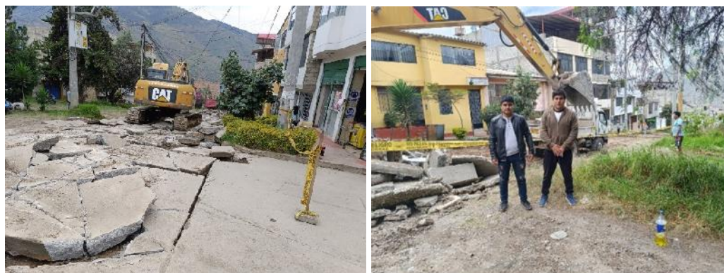
Figura 23 — Vía existente demolida
