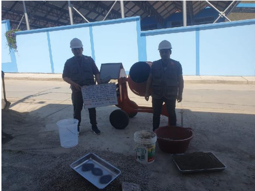
Figura 105 — Vaciado del concreto del GC
