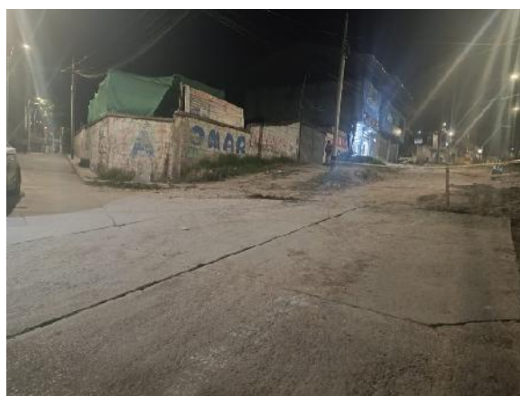
Figura 22 — Vía existente antes de ser demolida
