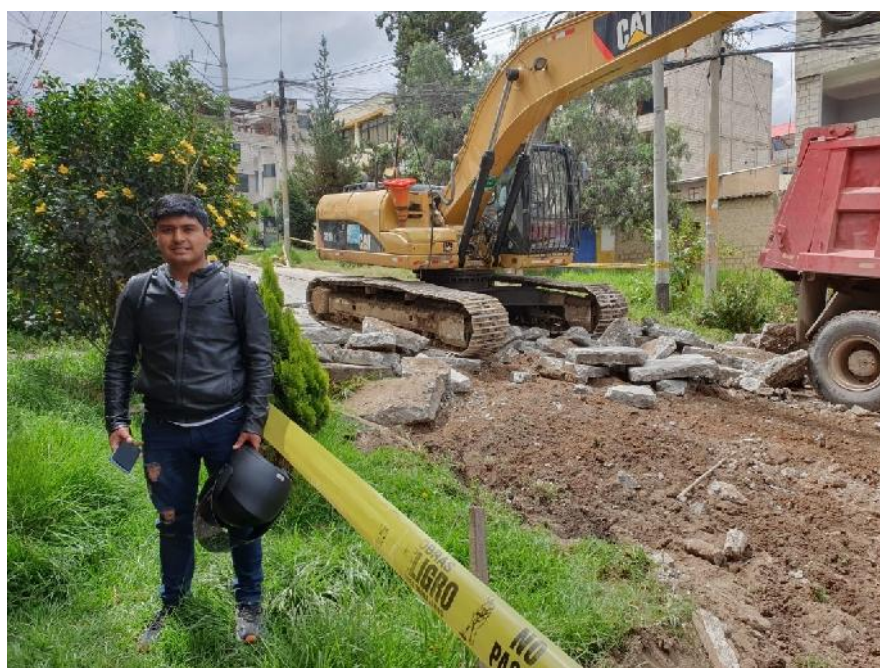
Figura 100 — Recolección de escombros de concreto
