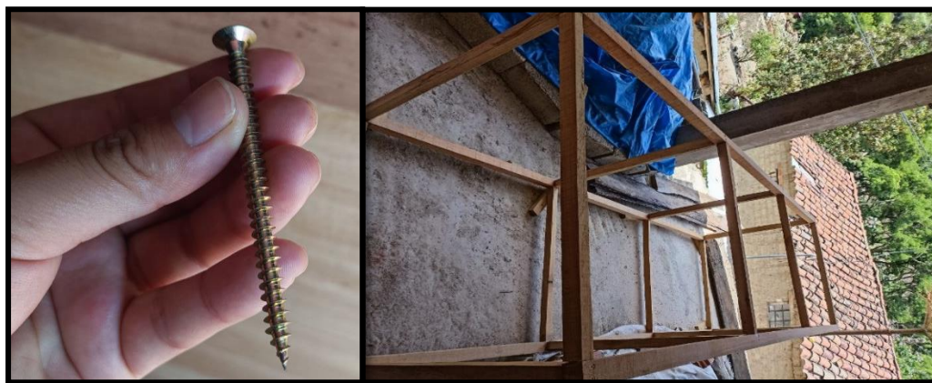
Figura 12 — Construcción de contenedor aeropónico, uso de tornillos
