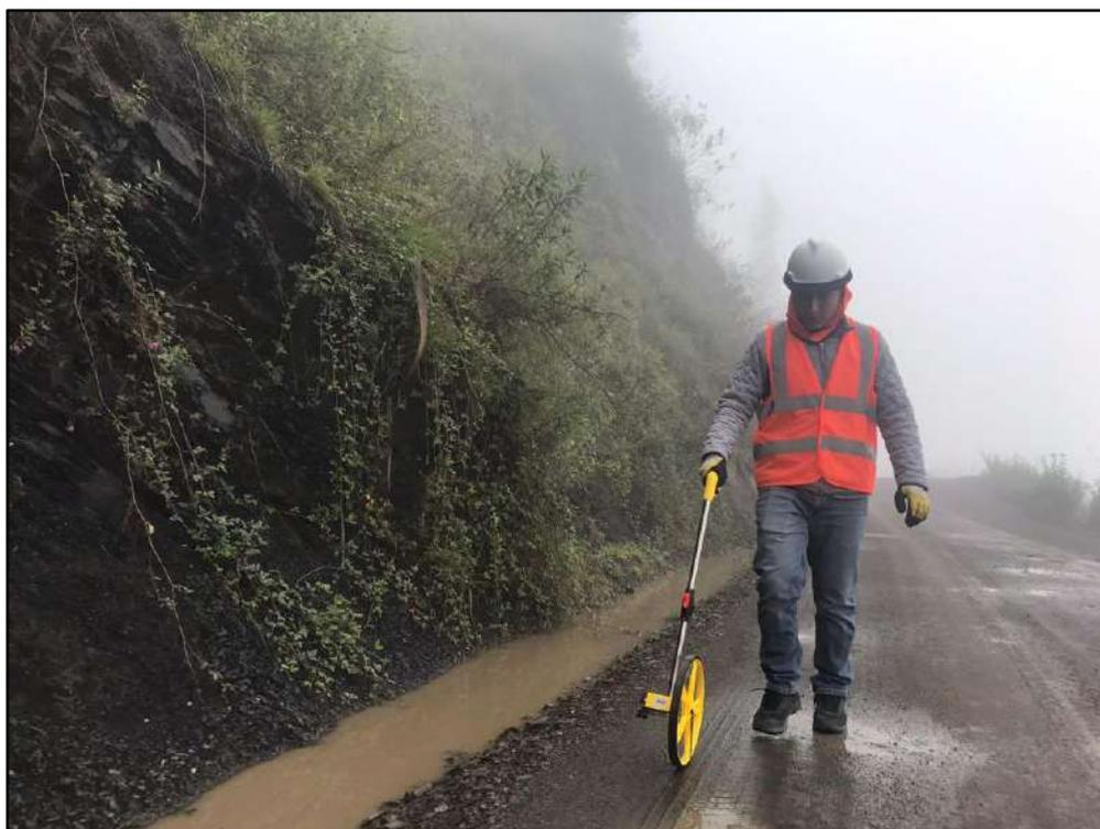
**Figura 81 — Medicion de fallas de drenaje lateral inadecuado para el analisis con la metodologia URCI**
