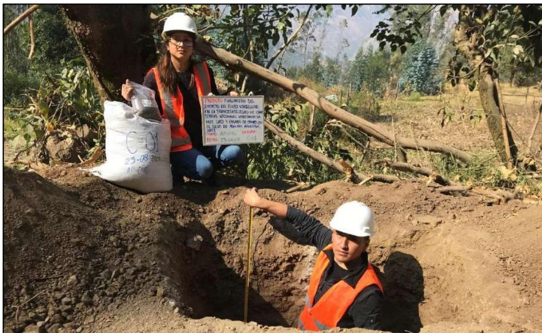
Figura 70 — Excavación de calicatas de la vía 1 para sacar muestras
