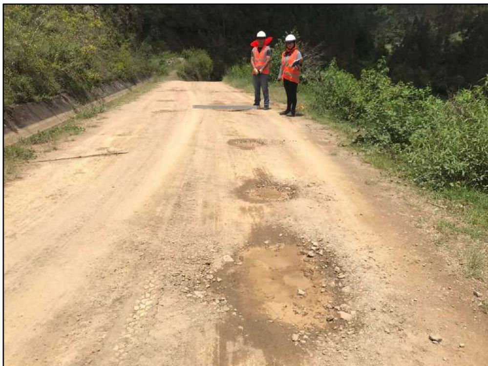
**Figura 82 — Medicion de fallas de baches para el analisis con la metodologia URCI**
