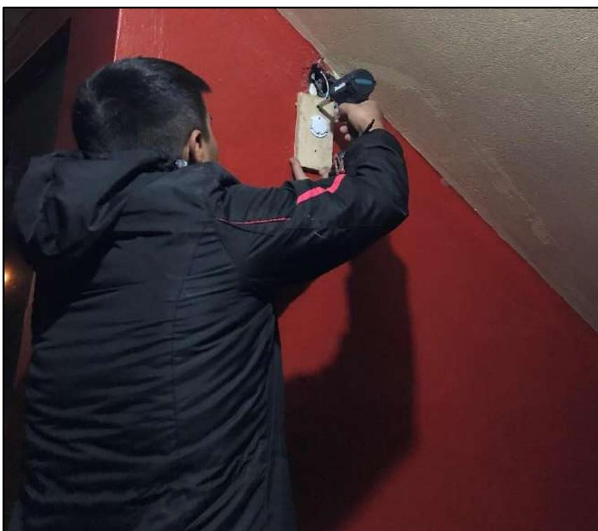
**Figura 75 — Colocacion de la camara de seguridad en la vía 1**
