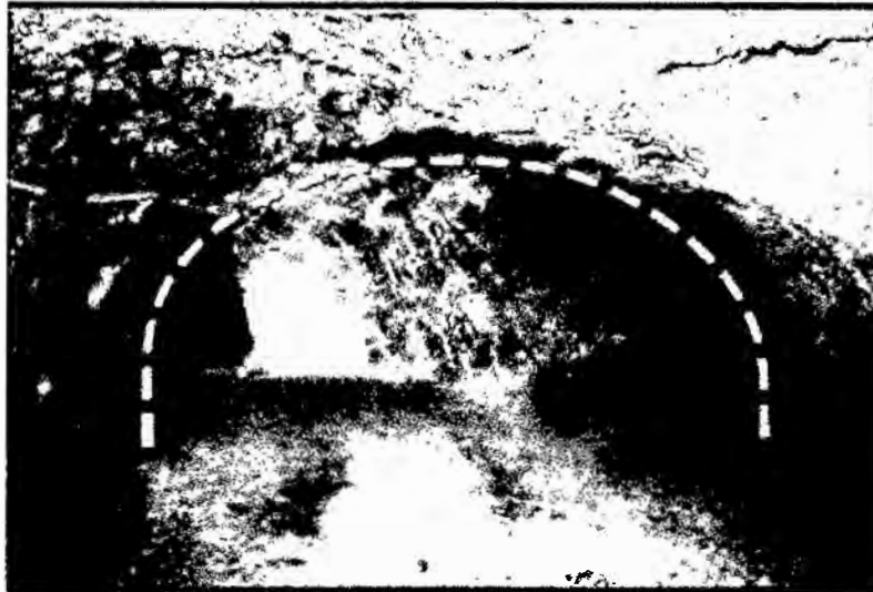
Figura N° 27. Forma favorable de una excavación.
