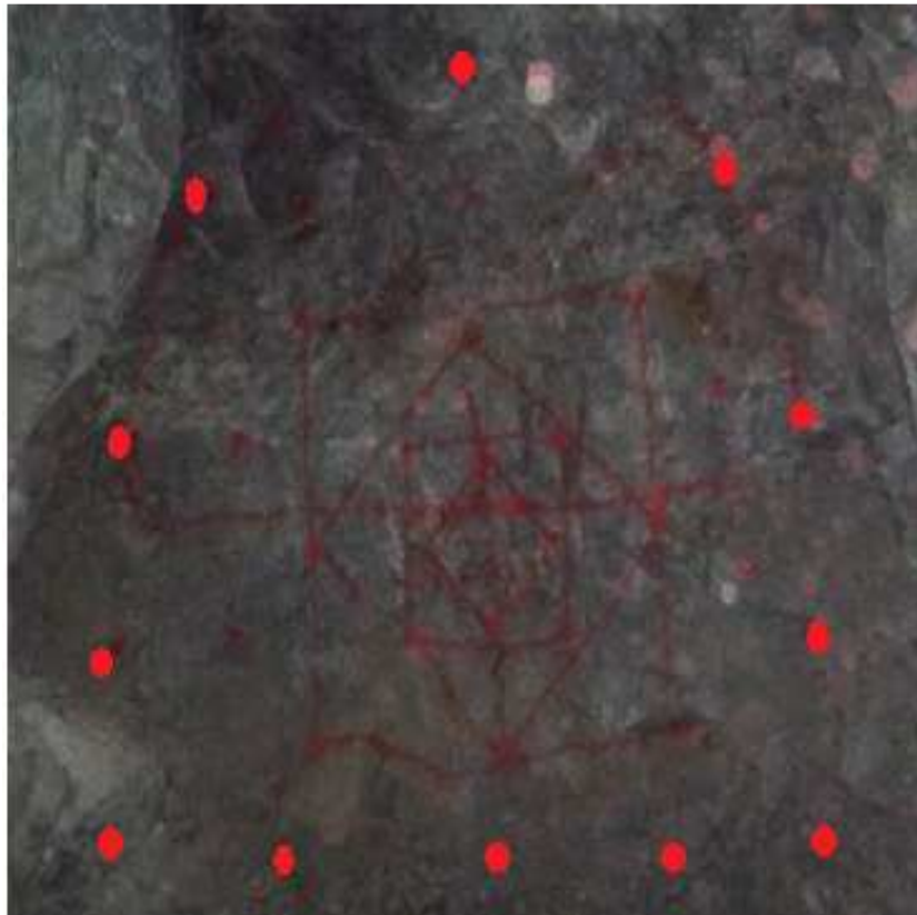
Figura 9. Pintado de malla de perforación
