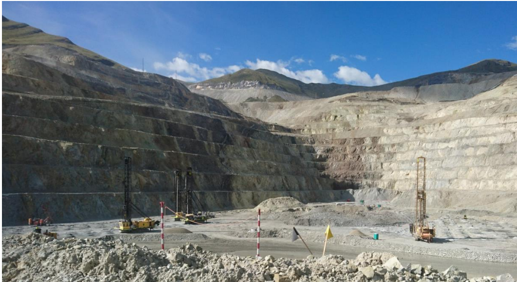
Figura 2: Proceso de perforación
