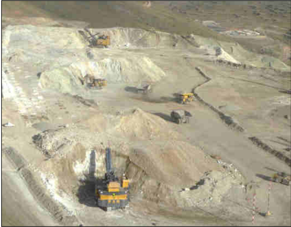
FOTOGRAFIA 2- 4. Minado de tres Palas en Nv. 3945
