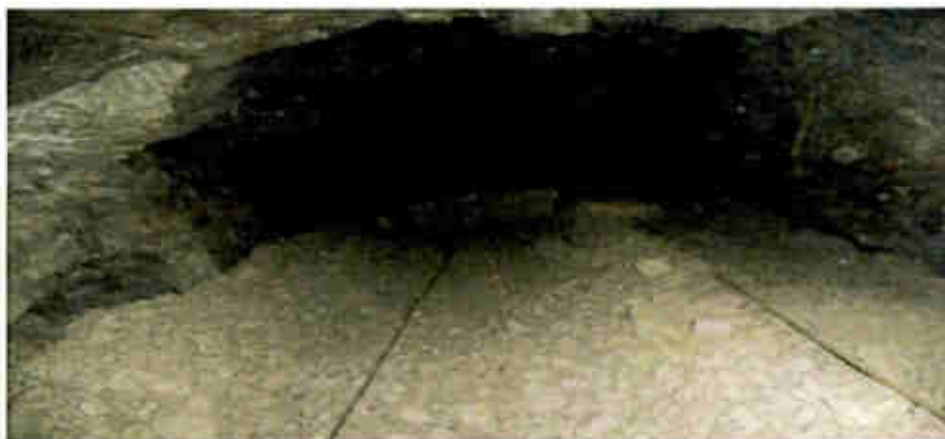
Fotografía muestra parte donde se termina de rellenar el tajo para realizar el carguio de explosivos y voladura
