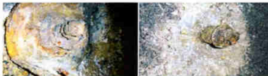
Fotografía 4. 4. Pruebas de tracción de "rs bolt" corroidos.
