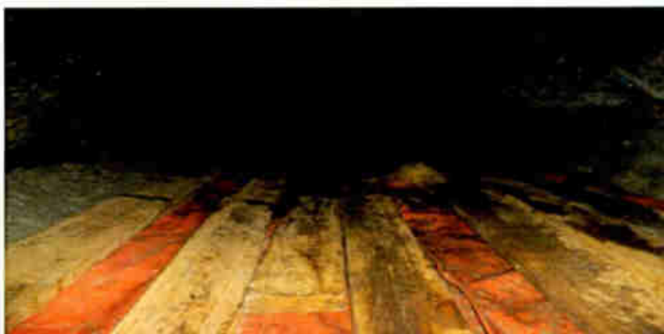
Fotografía muestra el piso con mangas y tablas para realizar el carguio de explosivos y voladura
