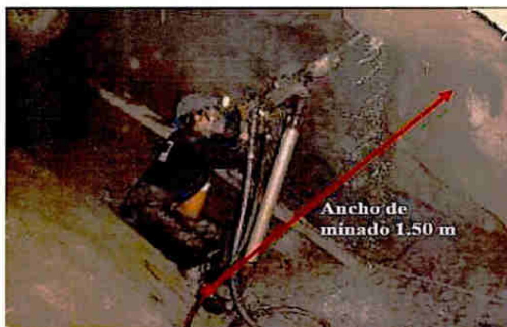
Fotografía 4. 2. Posición de perforación dada la estreches del ancho de minado
