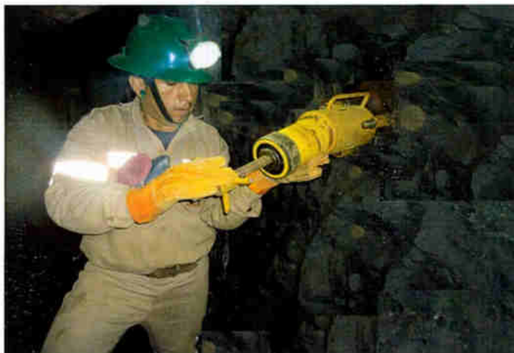
Fotografía 4. 6. Muestra el arranque de los soportes "Rs bolt" con el equipo "pull test" en el tajo 5960.
