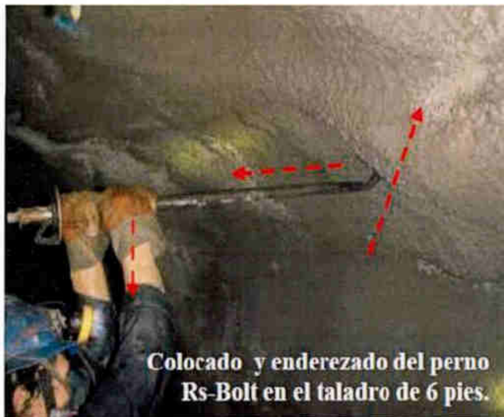
Fotografía 4. 3. Instalación del perno mediante el efecto palanca:
