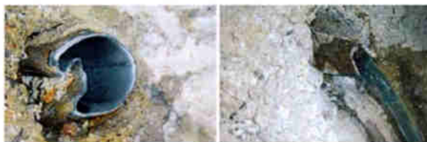
Fotografía 4. 5. Pruebas de tracción de "rs bolt".
