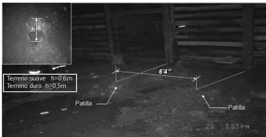
Figura N° 3.7: Elaboración de patilla para el soporte de enrejado
