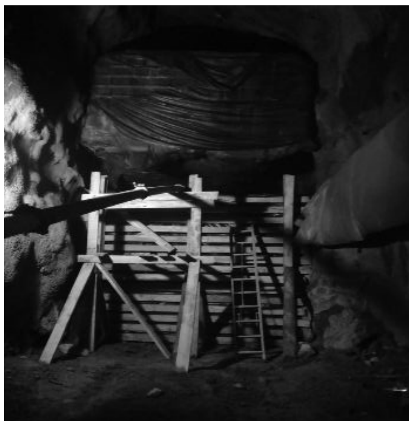
Fotografía N° 5: Vista panorámica de un encofrado terminado.
