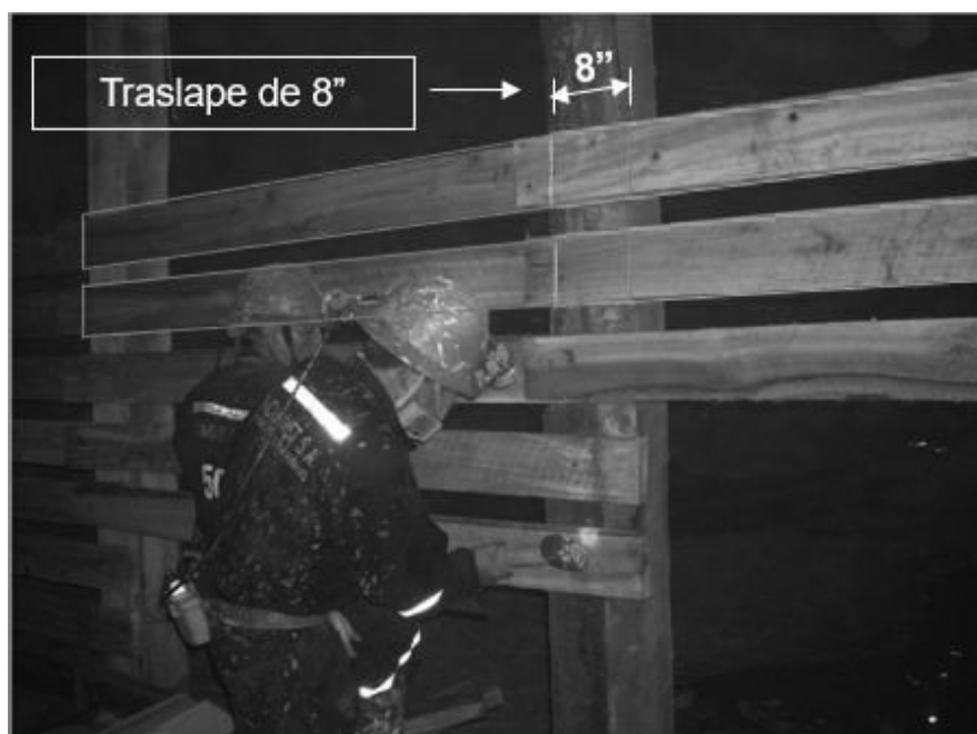
Figura N° 3.6 Enrejado e poste a poste
