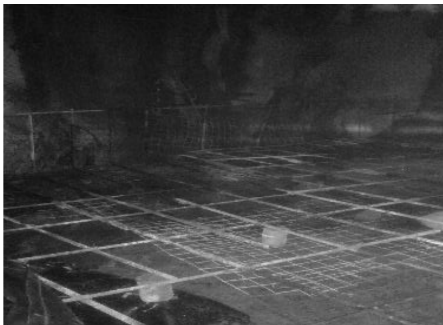
Fotografía N° 4: Colocación de adoquines en la base
