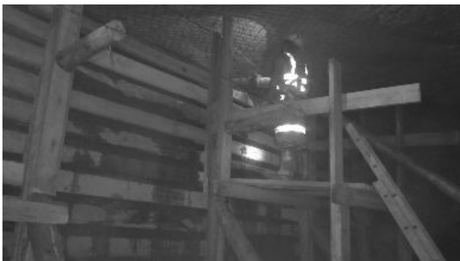
Fotografía N° 2: Aplicación del relleno cementado
