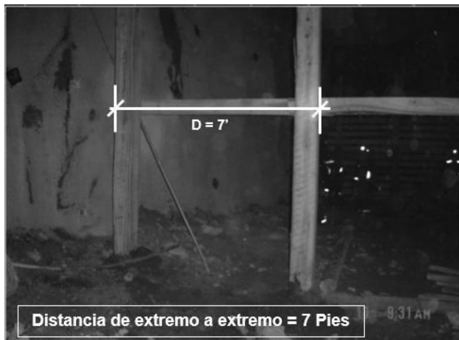
Figura N° 3.5: parado de postes
