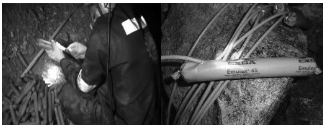
Fotografía 5: Encebado del explosivo Emulex 45% TJ 5105-1 Nv 1700.
