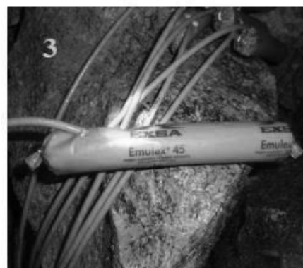
Encebado y carguío de taladros acumulados
