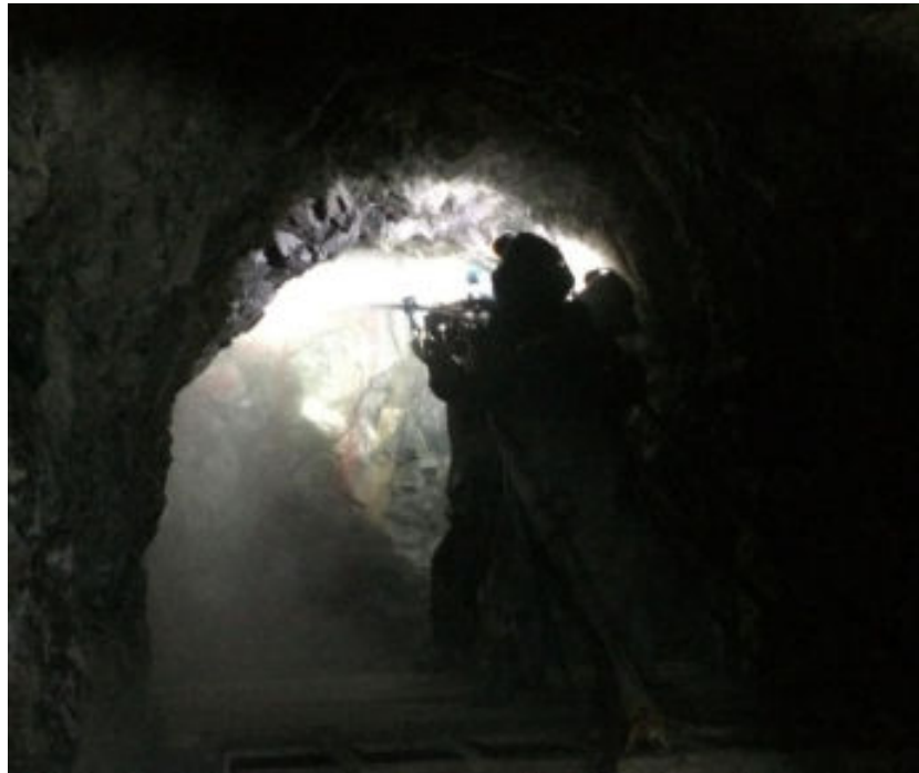
Figura N° 10 Perforación del frente de avance Carmen-Unidad Santa MARIA(CMPSA)
