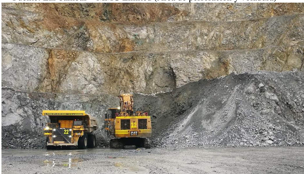
Figura 5.23: Minado del polígono 7 (Prueba 01). Fuente: Elaboración propia.
