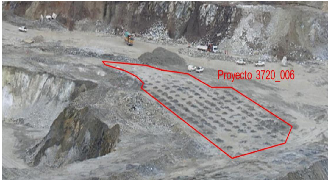
Figura 5.9: Malla de voladura con doble iniciación (línea base).
