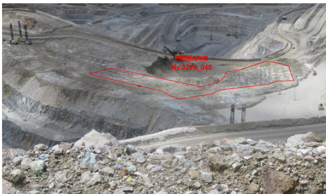
Figura 5.28: Malla de voladura con triple iniciación con carga satélite. Fuente: Elaboración propia.
