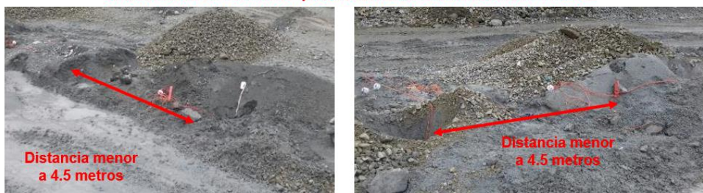
Figura 5.18: Taladros cercanos debido a re-perforación de taladros.
